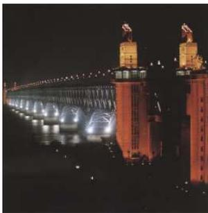
شكل رقم ٨٩-٩: الحصول على أفضل النتائج عندما يكون لون الضوء مقاربا للون السطح المضاء. إضاءة الهيكل المعدني بالمصباح الهاليد المعدني أما الطوب البني المصفر الخاص بالأبراج تسم إضاءتها بمصباح الصوديوم ضغط مرتفع. (Philips, 1993)
