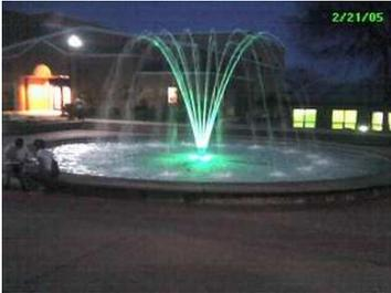
شكل رقم ٩-٢١٦: إضاءة أكثر من مخرج للمياه ناتج من فوهة واحدة باستخدام مجموعة من تركيبات الإنارة موجهة إلى أعلى تقوم بتغطية النافورة كلها بالإضاءة.
