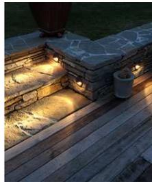
شكل رقم ١٩١-٩: الإضاءة الجانبية للسلم. يستخدم bollard في حالة عدم وجود حائط جانبي تثبت به تركيبية الإنارة.
