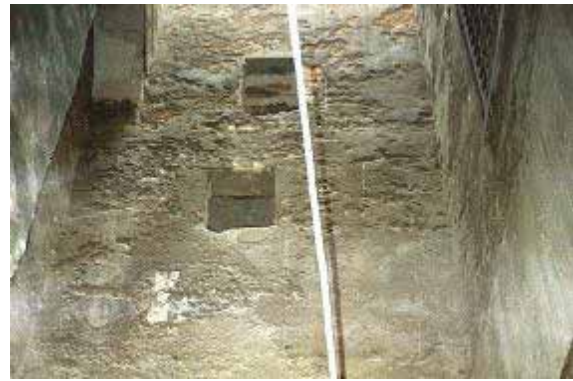
(شكل ٢ - ٦٠): جزء من القلعة مطلي بمونة الاسمنت الأسود. المصدر: وزارة الثقافة - المجلس الأعلى للآثار - آثار الإسكندرية (قلعة قايتباي)
