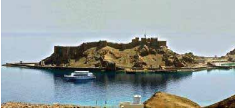
( شكل ٢ - ١٢٣ ): الأسوار المحيطة بجزيرة فرعون، يظهر المرسى الداخلي للقلعة . المصدر: الباحث .
