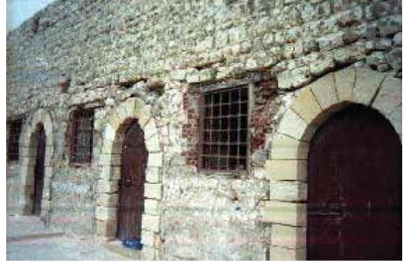
(شكل ٢ - ٦٤): الحواصل و قد تم تقشير المونة القديمة من عليها و ظهور تلف و تآكل بأحجار البناء. المصدر: وزارة الثقافة - المجلس الأعلى للآثار - آثار الإسكندرية (قلعة قايتباي)
