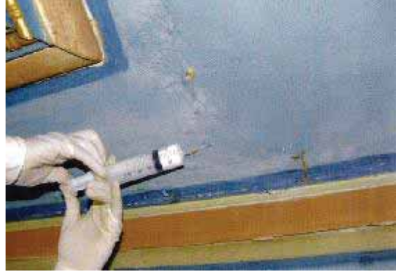
(شكل ٣ - ١١): حقن الزخارف بمواد مخصصة لتثبيتها . المصدر: مشروع ترميم قصر محمد علي بشبرا - القاهرة التاريخية
