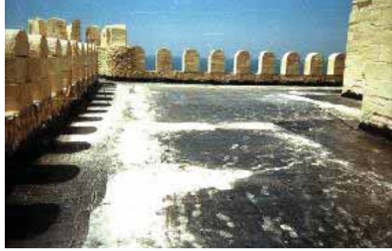
( شكل ٢ - ٦٨ ): عمل طبقة عازلة جديدة لممشى السور. المصدر: وزارة الثقافة - المجلس الأعلى للآثار - آثار الإسكندرية ( قلعة قايتباي )
