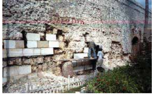
(شكل ٢ - ٦٦): فك الأحجار التالفة من الواجهات. المصدر: وزارة الثقافة - المجلس الأعلى للآثار - آثار الإسكندرية (قلعة قايتباي)
