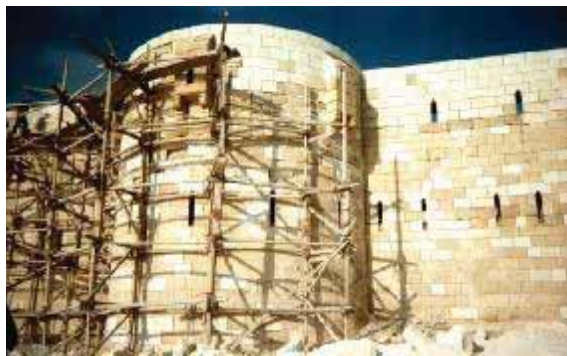
(شكل ٢ - ٦٣): استكمال العناصر المعمارية الناقصة. المصدر: وزارة الثقافة - المجلس الأعلى للآثار - آثار الإسكندرية (قلعة قايتباي)
