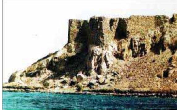
(شكل ٢ - ١١٤): احد أبراج السور الغربي للتحصين الشمالي قبل الترميم.
