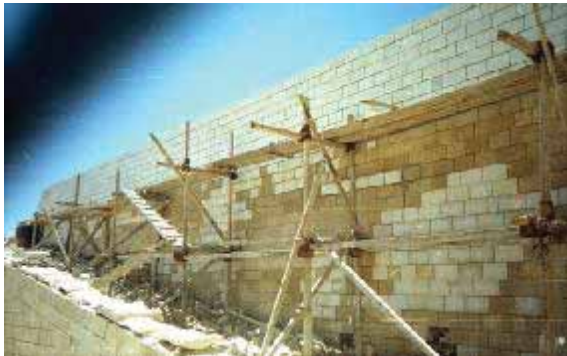
(شكل ٢ - ٦٧): استبدال الأحجار التالفة، التحكيل بمونة مناسبة. المصدر: وزارة الثقافة - المجلس الأعلى للآثار - آثار الإسكندرية (قلعة قايتباي)
