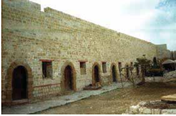
(شكل ٢ - ٦٥): الحواصل ببناء القلعة بعد استبدال الأحجار التالفة و التحكيل بمونة بيضاء مناسبة. المصدر: وزارة الثقافة - المجلس الأعلى للآثار - آثار الإسكندرية (قلعة قايتباي)
