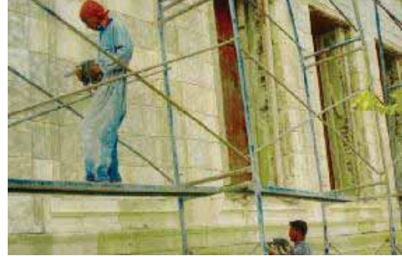
( شكل ٣ - ٩ ): تنظيف الواجهات بأجهزة السفع بحبيبات الرمال، أو نشارة الخشب الناعمة . المصدر: مشروع ترميم قصر محمد علي بشبرا - القاهرة التاريخية
