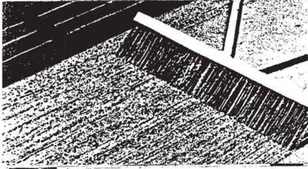
(شكل رقم ٩٨) التحكم في ملمس البلاطات الخرسانية بعد صبها في الموقع .
