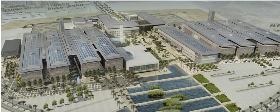
شكل رقم (٣-١٩) الأسقف التي تحمي المباني من أشعة الشمس (www.aiatopen.org)
