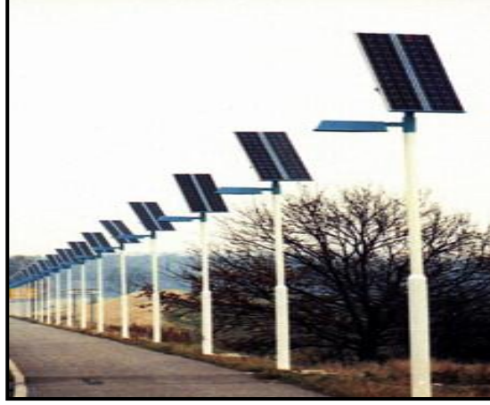
شكل رقم (٣٢-١): استخدام الخلايا الشمسية في أعمدة الإضاءة لتحقيق الاستدامة الاقتصادية والبيئية (www.pinterest.com)
