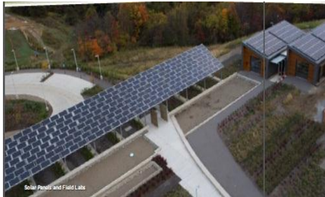
شكل رقم (٢٢-١) إدماج ألواح الطاقة الشمسية في المظلات لاستخدامها في توليد الكهرباء ( https://www.aia.org )
