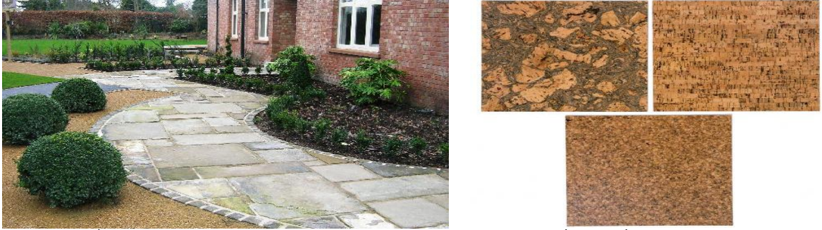
شكل رقم (٢٣-١) أشكال الأرضيات المسامية المستخدمة في الفراغات الخارجية لتجميع مياه الأمطار ( https://seminarprojects.blogspot.com.eg )
