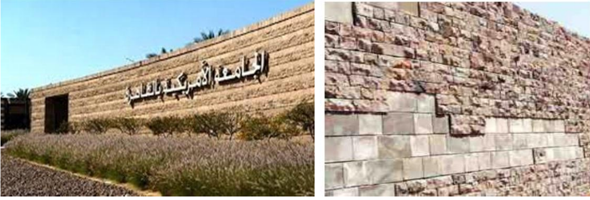
شكل رقم (٤٤-٣) استخدام الحجر الرملي في الاسوار والموقع العام بالجامعة الأمريكية بالقاهرة (AUCEGYPT.EDU.)
