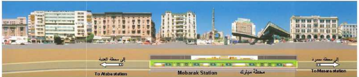
شكل 16 : مداخل محطة مترو مبارك بمرسى رمسيس Fig. 16 : Entrances to Mobarak station at Ramses Square
