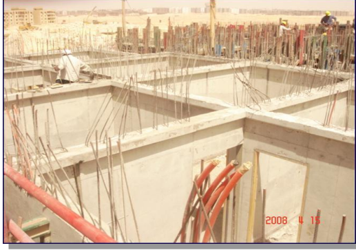
شكل(11): الانتهاء من الحوائط قبل وضع السقف
