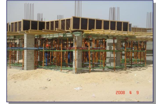
شكل(17): طول مدة التنفيذ لعمل شدة السقف الخشبية ورس حديد التسليح (حوالي أسبوع)
