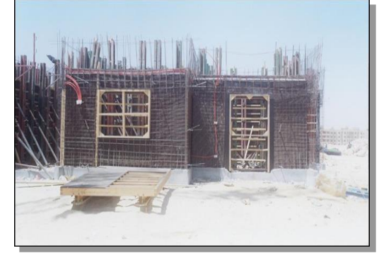
شكل(9): تسليح الحوائط الخرسانية قبل صبها
