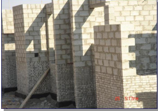
شكل(19): بناء الحوائط من البلوكات الأسمنتية والطوب
