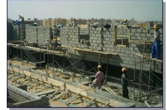
شكل(13): بناء الحوائط الحاملة أولاً
