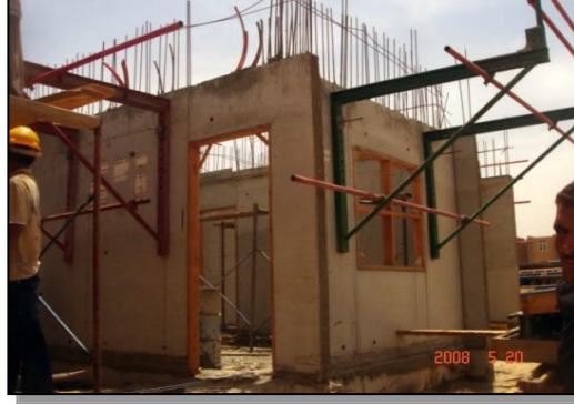
شكل(10): الحوائط الخرسانية بعد صبها
