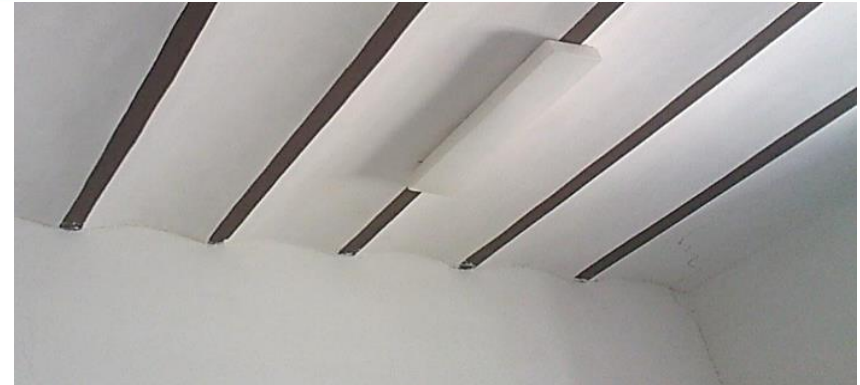
صورة السقف المقبب من الداخل Vaulted slab inside the room
