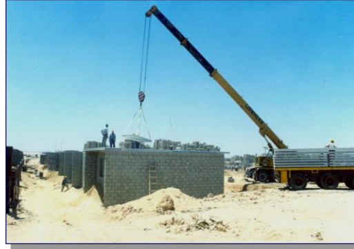
شكل(14): الاعتماد على الأوناش في وضع البلاطة الخرسانية سابقة الصب
