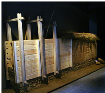
عملية ملاء التربة داخل الشدة على طبقات 15 سم للدمك اليدوي (Stulz&Mukerji 1981)
