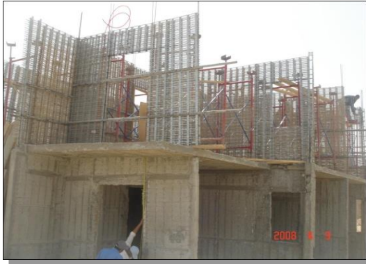
شكل (20أ،ب) حوائط وأسقف خرسانية بتسليح شبكي جاهز خفيف بدون استخدام قوالب لصب الخرسانة
