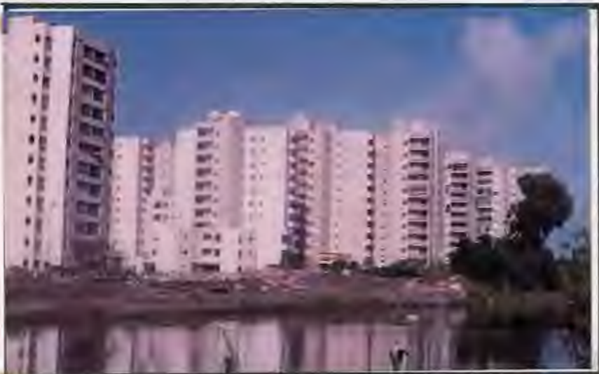
صورة (٤٩-٢) - مباني بحالة سيئة بعد كوبرى التاريخ بالجهة البحرية صورة (٥٠-٢) - بعض المباني بحالة سيئة بعد مصانع النحاس بالجهة البحرية صورة (٥١-٢) - أبراج سكنية بحالة ممتازة بالمنطقة الثالثة قبل كوبرى ١٤ مايو
