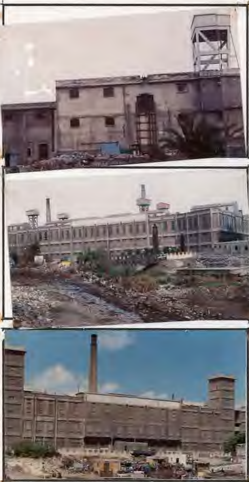
صورة (٢٢-٢) - مخازن البنك التجارى الطليانى بجوار كوبرى الهويس بالجهة البحرية صورة (٢٣-٢) - مخازن وابور القطن أمام الكوبرى المعدنى الأول بالجهة البحرية صورة (٢٤-٢) - مخازن تابعة لبنك مصر عند كوبرى التاريخ بالجهة القبلىة
