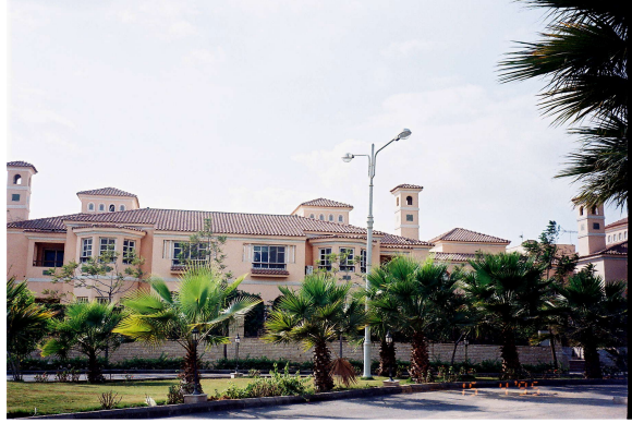
الواجهة الرئيسية للعمارات
