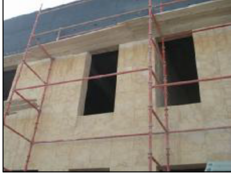
شكل (١٤) استخدام الجرانيت في التشييد
