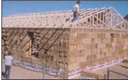
شكل (١٦) استخدام القش في التشييد
