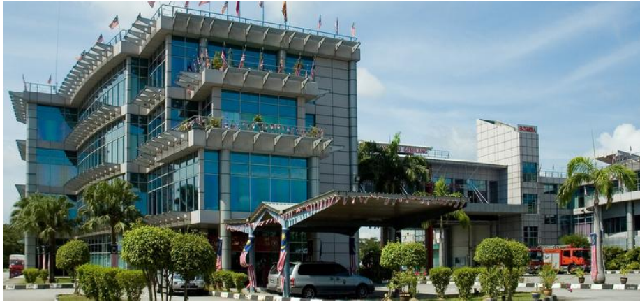
شكل (٣-٣٨) مركز الاطفاء (٢)
