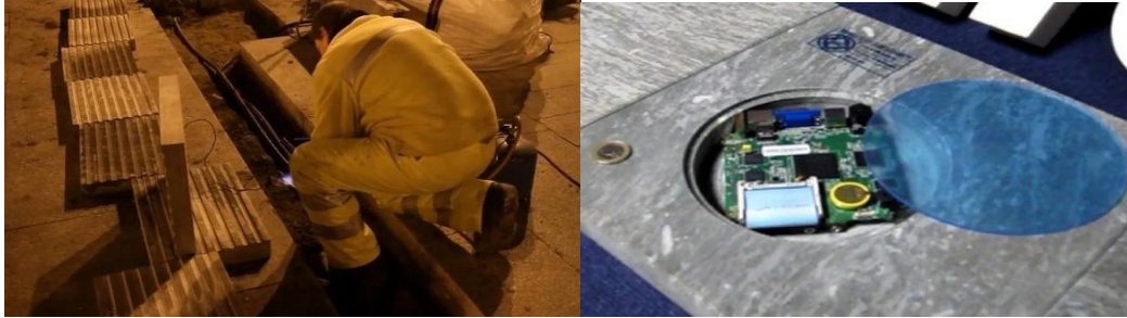
المعالج المثبت في نواة الحجر الذكية بتلك الأرصفة عملية تركيب الأرصفة الذكية
