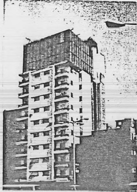
• نموذج للتناغم الشديد بين طراز العمارة الأمازيغية و طراز الأدوار المستعدة فوقها العمارة الأصلية تستخدم كسكن و الأدوار الزجاجية العلوية تستخدم كعبادة أسنان ( عمارة بشارع وزارة الزراعة بالدقي )
