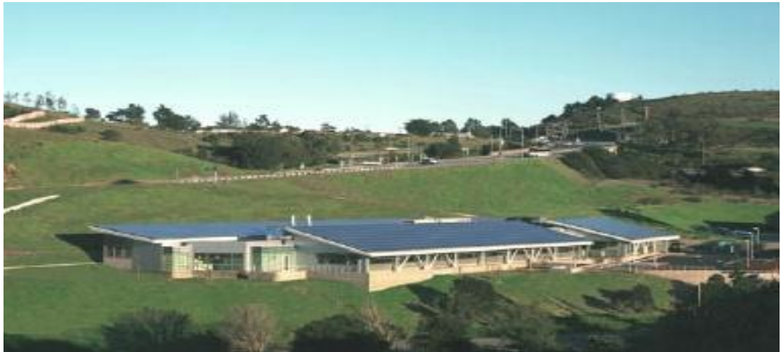
صورة جوية للمبنى
