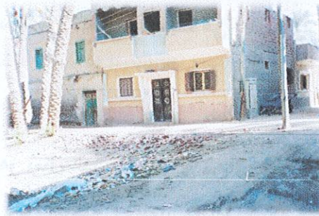
شكل (٢-٢) نموذج لمبنى حوائط حاملة ذات حالة متوسطة
