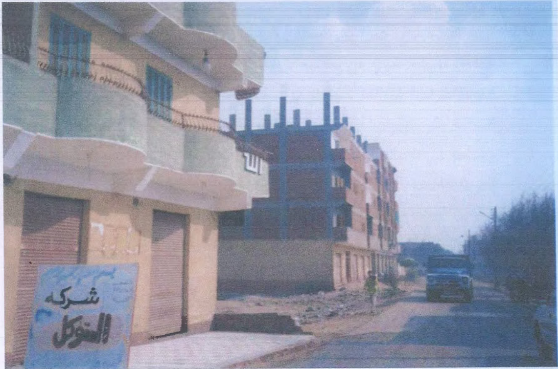
الامتدادات العمرانية الجديدة بالقرية ذات الطابع الحضري ( لاحظ الاعمدة الخرسانية فوق الاسطح للامتداد الراسى المستقبلى للمبنى )
