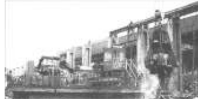
شكل (١): معالجة مخلفات المبنى لإنتاج الصلب. (م.٧٠، ص ١)
