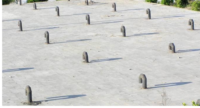
شكل 1 سطح خزان مياه أرضي تظهر مواسير التهوية للخزان بشكلها المنحني في حالة خشوع في مخيلة الناظر إليها وتلقى بظلالها على سطح الخزان دون إرادة منها ليتحرك على مدار اليوم مع حركة الشمس.
