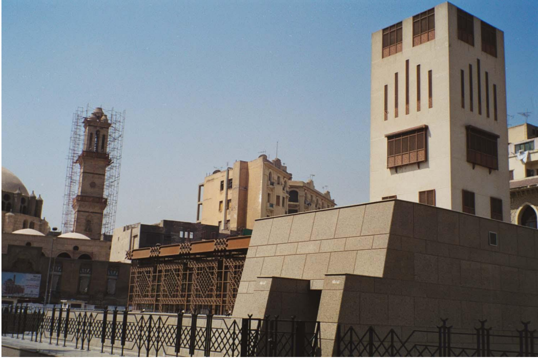
أبراج التهوية لنفق الأزهر من مواد حديثة وطابع خاص ولكنه مغاير للمنطقة وما بها من آثار إسلامية ذات طابع مميز.
