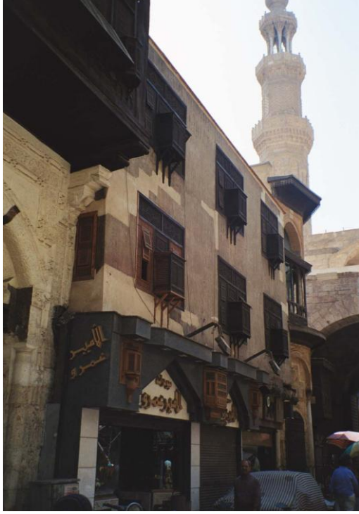
صورة توضح استخدام المشربيات في نمط متناسق في الواجهة بعد معالجة بيئية ناجحة واتزان جيد
