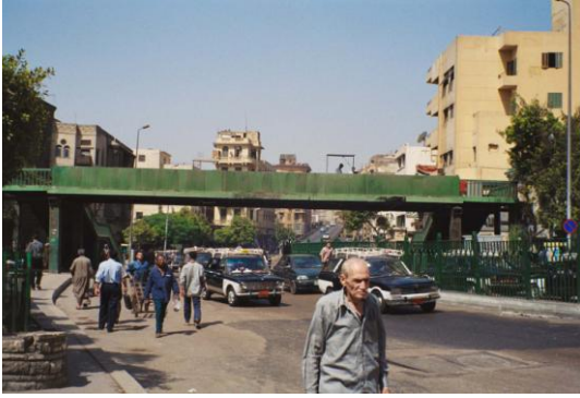
الكوبري الحديد الذي يعد عائقاً ومشوهاً بصرياً للمنطقة وكان من الممكن استخدام وسيلة من وسائل الإتصال البسيطة (نفق أسفل الطريق).
