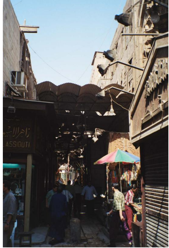
استخدام مواد حديثة ( معدنية ) في التظليل مما يشوه ويلوث ويحجب القيمة الأثرية للمباني ويعد معالجة غير بيئية
