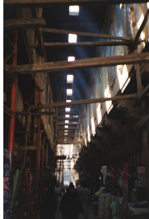
استخدمت في العصور السابقة التغطية الخشبية مع عمل فتحات للتهوية والإضاءة والتي تعد معالجة بيئية جيدة.
