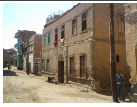
شكل (٢) : مسكن من النمط الريفي مبنى من الطوب اللبن قرية منيل غيضان - مركز اهناسيا محافظة بنى سويف
