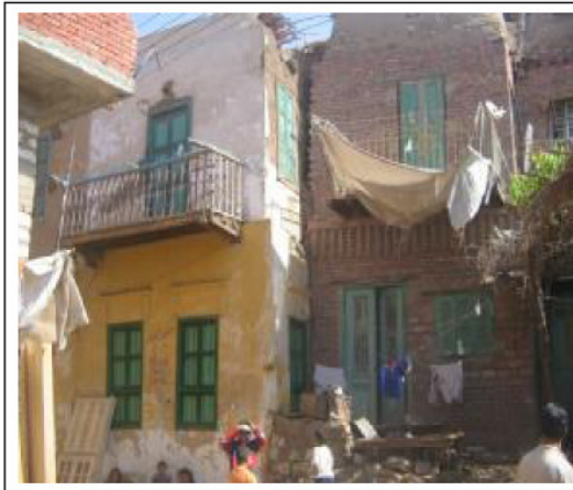
شكل (٣) : مسكن من النمط شبه الحضري مبنى من الحوائط الحاملة وأسقف خشبية أو خرسانية قريه بدهل - مركز سمسطا - محافظة بنى سويف
