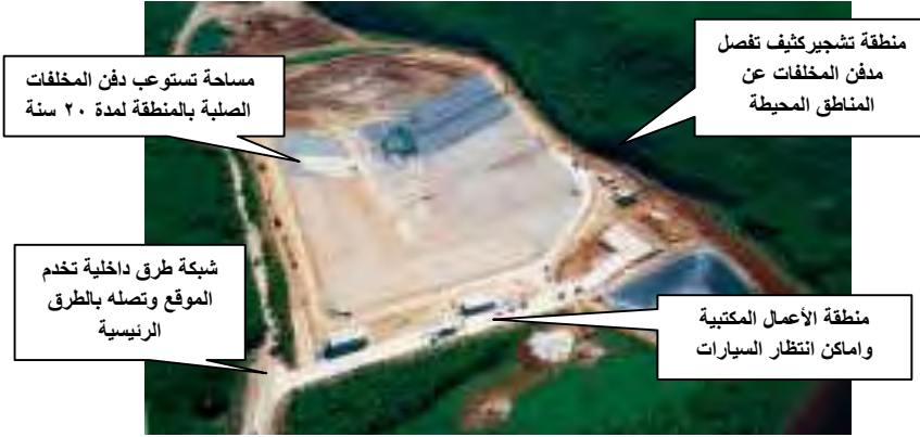
شكل ٤٢: منظر جوي للمدفن الصحي للمخلفات الصلبة - سايبان جنوب المحيط الهادئ ٥٢
