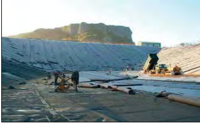
شكل ٤٣: تثبيت بطانة المدفن لحماية المياه الجوفية والترية- سايبان ٥٣
