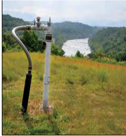
شكل ٣٩: قطاع يوضح مدفن صحي بعد غلقه وإمكانية إنتاج غاز الميثان ٤٨
