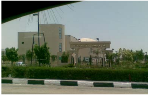
شكل رقم (12-35) يوضح نادي جاردينيا الواقع على طريق القاهرة - السويس بمنطقة المدخل.
