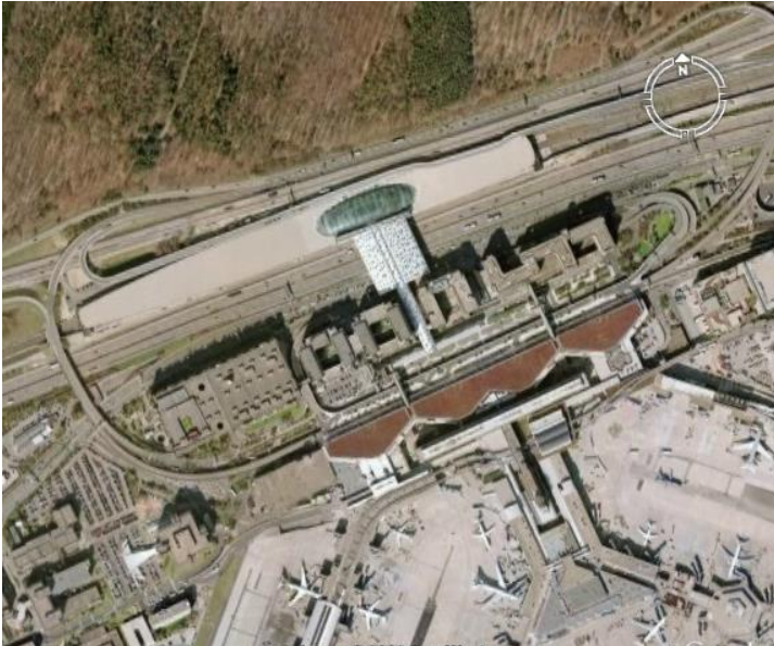
الشكل رقم(5-41) يوضح المبنى الرئيسي للمطار ومحطة القطار على اتصال مباشر به. 2
