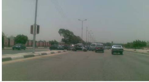
شكل رقم (27-12) يوضح نموذج لفتحة بالجزيرة الوسطى تؤدي بصورة قاطعة لحدوث اختناقات مرورية بطريق القاهرة السويس.
