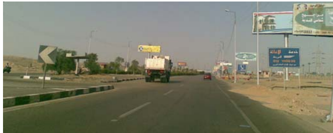
شكل رقم (12-30) يوضح نموذج لفتحة بالجزيرة الوسطى (U-Turn) بطريق القاهرة السويس.
