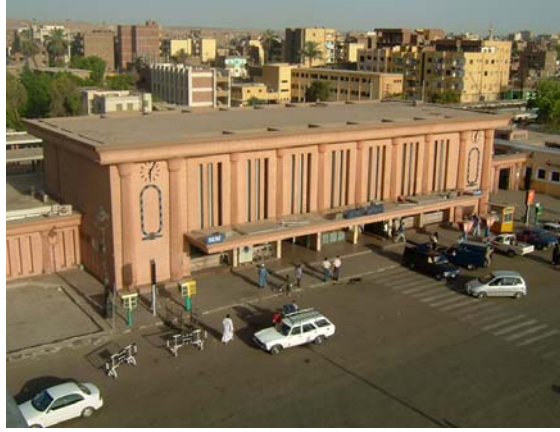
شكل رقم (1-8ج)- صورة لمحطة أسوان للسكك الحديدية توضح مخرج المحطة علي المنطقة المحيطة بها التي تعتبر مدخل لمدينة أسوان من المحطة 1
