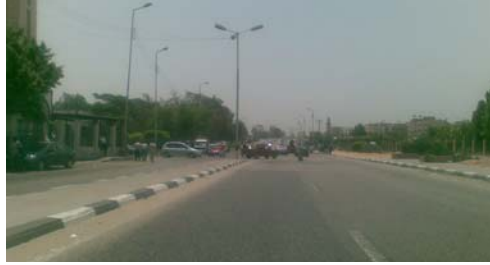
شكل رقم (12-29) يوضح نموذج لفتحة بالجزيرة الوسطى تؤدي بصورة قاطعة لحدوث اختناقات مرورية بطريق القاهرة السويس.
