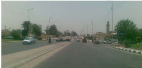
شكل رقم (28-12) يوضح نموذج لفتحة بالجزيرة الوسطى تؤدي بصورة قاطعة لحدوث اختناقات مرورية بطريق القاهرة السويس.
