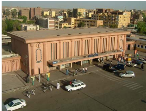
شكل رقم (12-47) يوضح صورة لمبنى محطة أسوان وجزء من الفراغ عند مخرجها.
