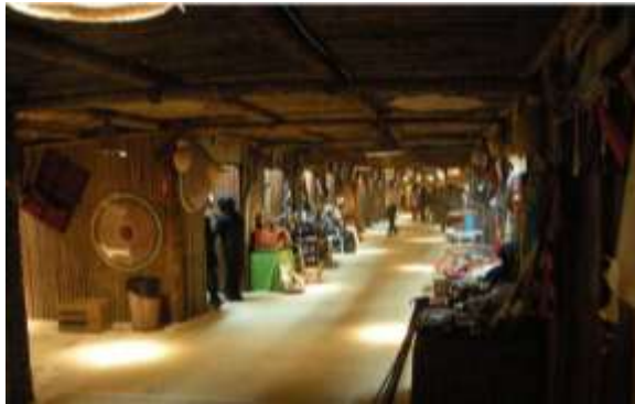
شكل 1- 25 سقف مستوي من جذوع نخيل التمر مع جريد النخيل في واحة القطارة التراثية في العين بالامارات المصدر: Ahmed Hamdan, 'Al Qattara Arts Centre', in Trip Advisor <> [accessed 5 November 2015]
