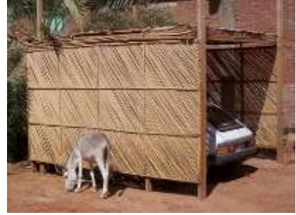
شكل 1- 36 مظلة و قواطع خفيفة من الجريد المصدر: عبد الوهاب حنفي، 'جريد النخيل. صناعة تتناهب in فولكلور سكان الصحري المصرية [accessed 16 <http://elbadil.com/2015/08/02/>] 16 نوفمبر 2015
