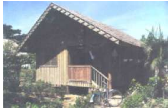
شكل 1- 24 سقف جمالوني من الخشب المصنع من جذوع نخيل جوز الهند في كينيا المصدر: Killmann Wulf and Fink, Dieter, Cocunut Palm Stem Processing (Eschborn, Germany: Department of Furniture and Wooden Products, 1996) (p. 9).
