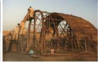
شكل 3- 59 تثبيت الحصير المصنوع خارج الموقع
