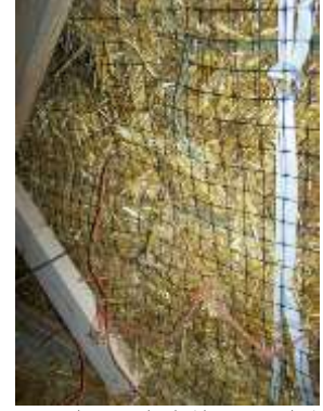
شكل 2- 19 الشبك المعدني الممدد و شبكات الكهرباء
