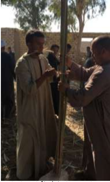
شكل 5- 18 تجميع الحزم: يتم الربط بأربطة البلاستيك على مسافات متباعدة. المصدر: الباحث.
