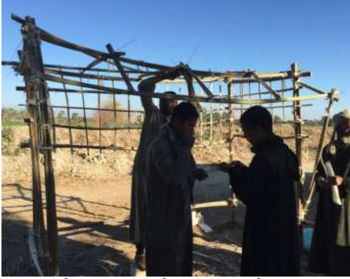
شكل 5-30 تثبيت المظلة: يتم وضع كمره عرضية للربط بين دعائم المظلة ثم وضع دعائم متوسطة. المصدر: الباحث
