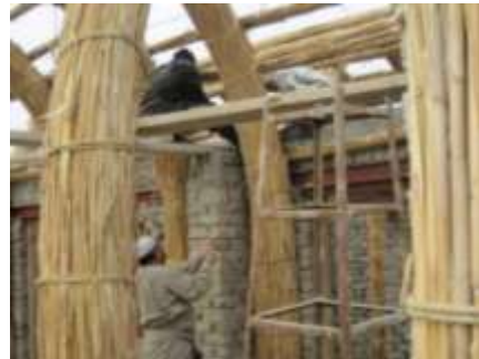
شكل 3-38 دمج نظام الحزم العقدية مع الحوائط الطينية تحت اشراف الجيش الامريكي
