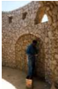
شكل 1- 14 مشاركة الشباب السيوي في تركيب قطع أحجار الحجر الجيري في تشكيل الحوائط المصدر: Alamuddin, Hanan, Adrere Amellal Eco Lodge Technical Review Report (Siwa Oasis, Egypt: Siwa Sustainable Development Initiative, 2001) (p. 54).
