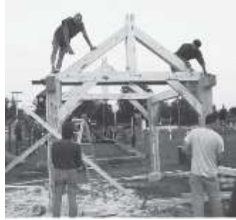
شكل 3-2 الإطار الهيكلي و اعتماده الكامل على المفصلات الخشبية المصدر: Magwood, Chris, Building Better Buildings: A Comparative Guide to Sustainable Construction (Gabriola Island, Canada: New Society Publishers, 2014) (p. 161).
