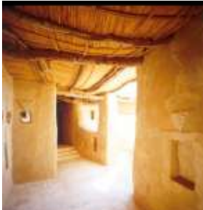
شكل 1- 12 التسقيف بجنوع انخيل و الجريد في فندق Adrere Amellal Ecolodge في واحة سيوة المصدر: Alamuddin, Hanan, Adrere Amellal Eco Lodge Technical Review Report (Siwa Oasis, Egypt: Siwa Sustainable Development Initiative, 2001).
