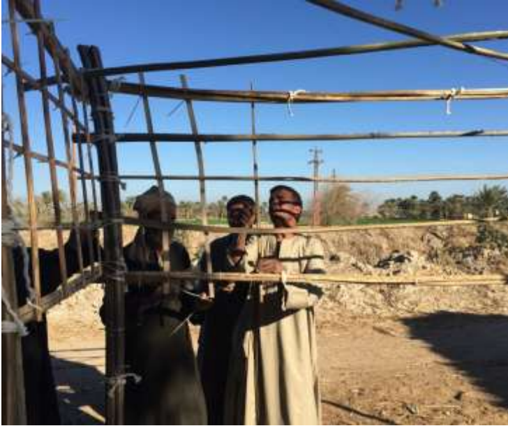
شكل 5- 28 وضع العناصر الرأسية للواجهات: يتم وضع العناصر الرأسية بالشبكة. المصدر: الباحث.
