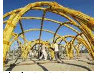
شكل 5- 3 تجميع عناصر الجريد على هيئة حزم في نظام الحزم العنقودية المتقاطعة في الإمارات المصدر: Peter Shehan, 'Palm Leaves Food Shelter', in Design Boom News Letter < http://www.designboom.com/architecture/sandra-piesik-3-ideas-ltd-food-shelter-the-sabla-al-ain-unesco-03-27-2015/ > [accessed 22 September 2015]
