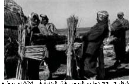
شكل 3- 32 تحزيم البوص قبل البداية في الانشاء بوضع البوص القديم في المنتصف و ضعف السمك من البوص الحديث المرن
