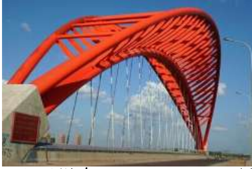
شكل 5- 57 جسر Changchun Yitong في شنغهاي، يتضح حدوث الاتزان بسبب تقابل العقدتين المائلتين و هو مثال على الجمالون العقدي الهلالي
