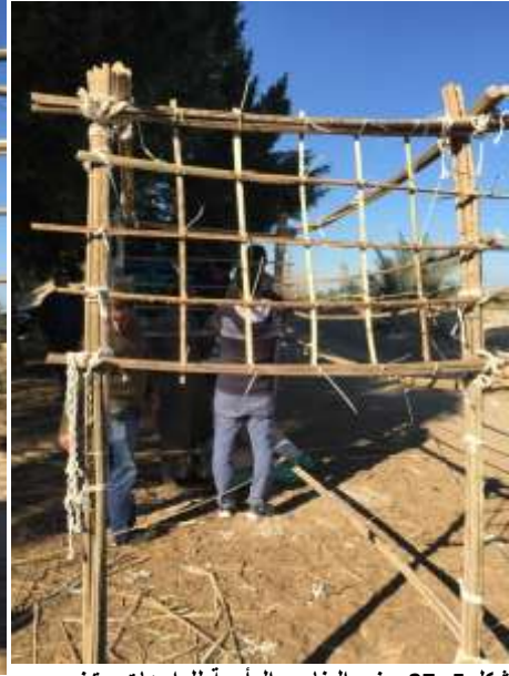
شكل 5- 27 وضع العناصر الرأسية للواجهات: يتضح ربط العناصر الرأسية بالكمرات و العناصر الأفقية. المصدر: الباحث.
