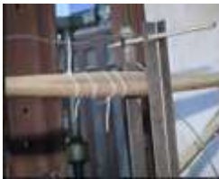
شكل 5- 44 استخدام الاربطة البلاستيكية لجمع العناصر.
