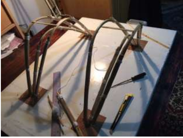
شكل 5- 65 عمل العقدین الثلاثیین: استخدام عنصر مبدئي للحفاظ على الميول المطلوبة للعقود المائلة. المصدر: الباحث
