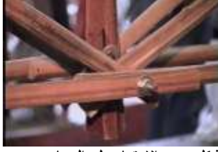
شكل 5- 47 الاعتماد على المسامير في المفصلات. المصدر: Raga, Tamer (MSc Thesis, Ain Shams University, Department of Engineering, 2010), p. 141.
