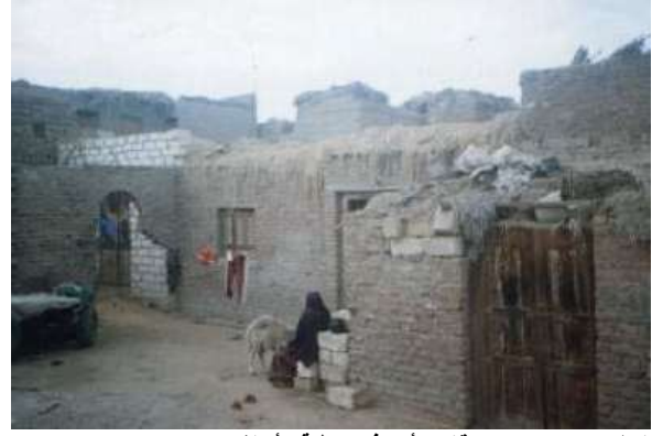
شكل 2- 28 استخدام قش الأرز في تغطية الأسقف المصدر: أيمن عقبة and عفيفي، إيهاب، "استخدام المخلفات الزراعية في المنشآت الريفية in, مؤتمر مستقبل التنمية المستدامة في مصر (القاهرة، مصر: وزارة التنمية المحلية المصرية، 184-99.2012، II, (ص.7)
