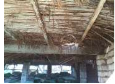
شكل 2- 53 التسقيف بسدة الجريد من الداخل المصدر: الباحث في رحلة ميدانية لقرية القايات بمحافظة المنيا
