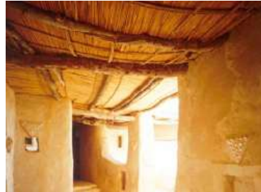
شكل 2- 54 التسقيف بجذوع النخيل و الجريد في فندق Adrere Amellal المصدر: Alamuddin, Hanan, Adrere Amellal Eco Lodge Technical Review Report (Siwa Oasis, Egypt: Siwa Sustainable Development Initiative, 2001) (p. 47).
