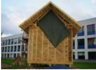
شكل 3- 46 الحوائط المشكلة بالبوص العرضي قبل التغطية بالطين و التسقيف بنظم Thatch المصدر: Miljan, Matix, Miljan, Martti and Miljan, Jaan, 'Construction of Test House with Reed Insulated Enclosures, Materials and Time Used during the Construction', in GUIDEBOOK OF REED BUSINESS (Finland: European Regional Development Fund, 2013), pp. 30-36 (p. 3).
