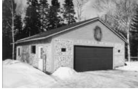
شكل 3- 5 جراج Earthwood المنفذ بالكامل باستخدام إطار هيكلي بسيط لتغطية بحر 8.5م.
