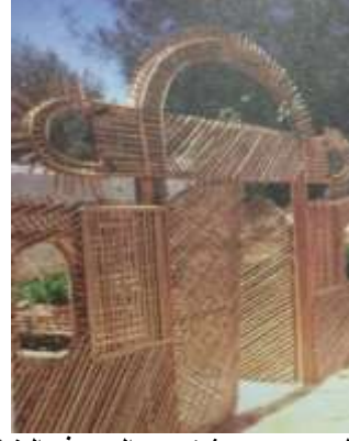
شكل 3- 75 سور شبكي من الجريد في المنيا. المصدر: الجمعية المصرية للتنمية الذاتية للمجتمعات المحلية، ' النخلة: كمصدر للخامات الصناعية و مواد البناء', 2004.
