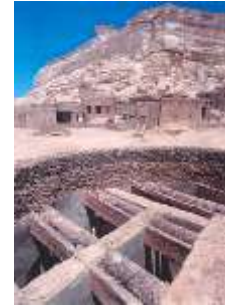
شكل 1- 10 استخدام جنوع النخيل في التسقيف في فندق Adrere Amellal المصدر: Alamuddin, Hanan, Adrere Amellal Eco Lodge Technical Review Report (Siwa Oasis, Egypt: Siwa Sustainable Development Initiative, 2001) (p. 20).
