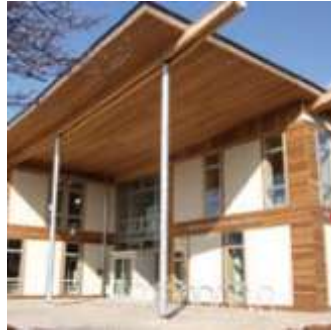
شكل 3- 21 الأسقف و الحوائط باستخدام التجاليد الخشبية و البياض الاسمنتي. المصدر: Modcell Straw Technology: Technical Guide, www.modcell.com edn (London,UK: Executive, European Commission Agency for Competitiveness and Innovation (EACI), 2015) (p. 3).
