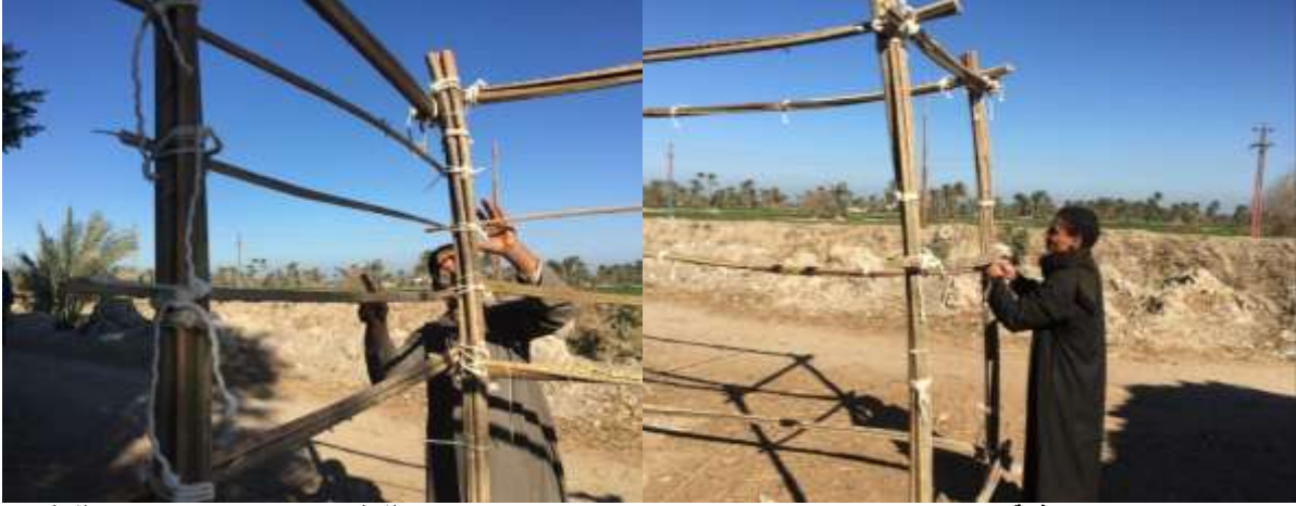
شكل 5- 25 وضع العناصر الأفقية للواجهات: عمل الكمرات و الثقيل على المفصلات بحبال الكتان. المصدر: الباحث.
