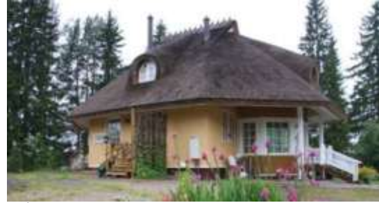
شكل 3- 52 حوائط من البوص العرضي بعد البياض و Thatch للسقف في مبنى في فنلندا
