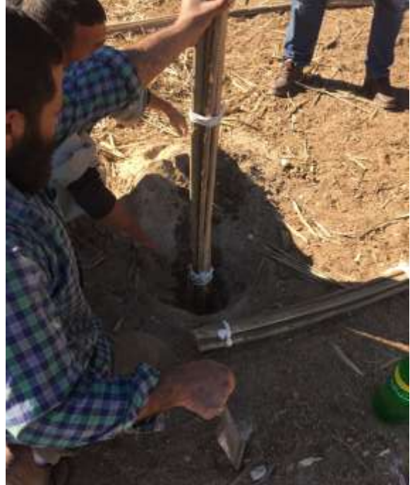
شكل 5- 21 غرس الأعمدة: يتم الحفر ثم صب الماء و "تهييل" التربة من الجوانب و دكها المصدر: الباحث
