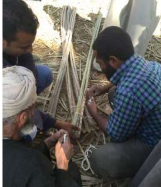
شكل 5- 19 التفقيط بحبال الكتان: يتم فك حبال الكتان المجدول لتكون أرفع و أكثر قدرة على الربط المصدر: الباحث
