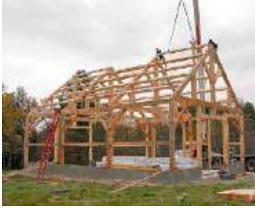
شكل 3-3 إطار هيكلي باستخدام المفصلات الخشبية ببحر 9 متر يتكرر كل 5 متر المصدر: Kennedy, Joseph, Smith, Micheal and Wanek, Catherine, The Art of Natural Building , 2nd edn (Gabriola Island, Canada: New Society Publishers, 2015) (p. 678).
