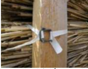
شكل 3- 49 وسيلة الربط بالبلاستيك بين الاطار الخشبي و البوص العرضي الحر المصدر: Miljan, Matix, Miljan, Martti and Miljan, Jaan, 'Construction of Test House with Reed Insulated Enclosures, Materials and Time Used during the Construction', in GUIDEBOOK OF REED BUSINESS (Finland: European Regional Development Fund, 2013), pp. 30-36 (p. 5).
