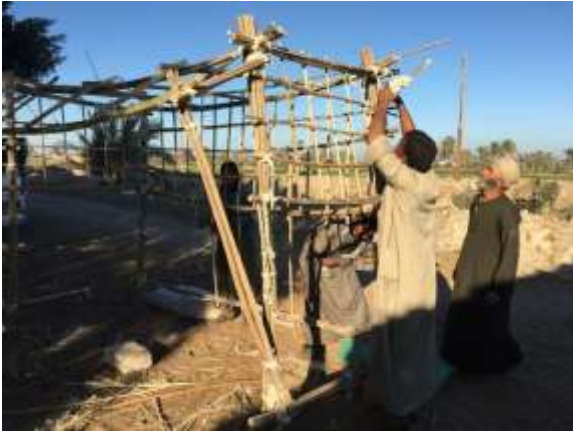
شكل 5-32 التقفييل النهائي للنظام الانشائي: يتم المرور على جميع المفصلات و التقاطعات بخيط مستمر من حبال الكتان. المصدر: الباحث
