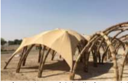
شكل 5- 36 نظام القبو المتقاطع: ضرورة الانضباط على الوحدة الموديلية للامتداد المصدر: Peter Shehan, 'Palm Leaves Food Shelter', in Design Boom News Letter < http://www.designboom.com/architecture/sandra-piesik-3-ideas-ltd-food-shelter-the-sabla-al-ain-unesco-03-27-2015/ > [accessed 22 September 2015]
