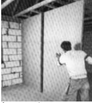
شكل 2- 27 أعمال التركيب لقواطع الألواح المضغوطة من قش الأرز المصدر: أيمن عقبة and عفيفي، إيهاب، "استخدام المخلفات الزراعية في المنشآت الريفية in, مؤتمر مستقبل التنمية المستدامة في مصر (القاهرة، مصر: وزارة التنمية المحلية المصرية، 184-99.2012، II, (ص.12)
