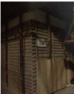
شكل 3- 74 الحائط الشتوي منخفض النفاذية المصدر: Piesik, Sandra, Arish: Palm-Leaf Architecture, 2nd edn (London, UK: Thames & Hudson, 2012) (p. 168).
