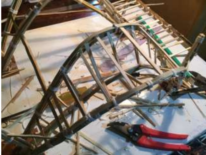
شكل 5- 71 تثبيت الدعامات الأفقية: ربط حزم العقود بالحبال لضمان عدم وجود فراغات داخل الحزمة نتيجة ادخال اطراف الدعامات بها. المصدر: الباحث
