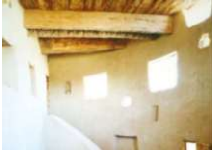
شكل 1- 11 التسقيف باستخدام جنوع النخيل و الجريد في فندق Adrere Amellal المصدر: Alamuddin, Hanan, Adrere Amellal Eco Lodge Technical Review Report (Siwa Oasis, Egypt: Siwa Sustainable Development Initiative, 2001) (p. 47).
