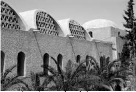
شكل 3- 41 الأقبية النوبية من الطوب في النوبة
