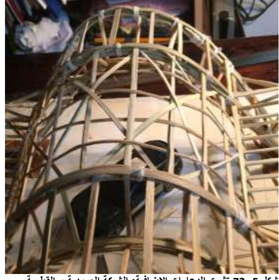
شكل 5- 72 تثبيت الدعامات الإضافية: الشبكة العمودية و القطرية لتغطية القبو. المصدر: الباحث.
