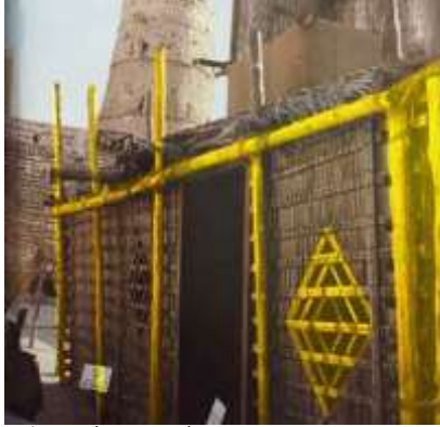
شكل 5- 108 التدعيم الخارجي باستخدام أعمدة ركنية من جذوع النخيل أو أشجار الزيتون في التكسية بالجريد المجدول المصدر: Piesik, Sandra, Arish: Palm-Leaf Architecture , 2nd edn (London, UK: Thames & Hudson, 2012) (p. 131).
