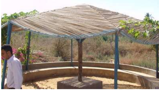
شكل 1- 37 مظلة خفيفة من الجريد في الواحات البحرية المصدر: عبد الوهاب حنفي، 'جريد النخيل. صناعة تتناهب in فولكلور سكان الصحري المصرية [accessed 16 <http://elbadil.com/2015/08/02/>] 16 نوفمبر 2015
