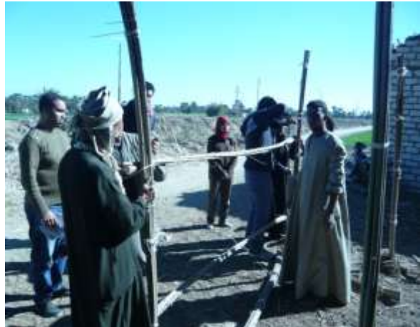
شكل 5- 23 تثبيت العناصر الرئيسية: وضع الكمرات الأفقية الفرعية في الواجهة الشمالية. المصدر: الباحث
