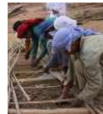
شكل 1- 19 تشكيل الاسقف البوص على الارض قبل البناء
