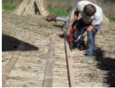
شكل 3- 48 تشذيب أطراف البوص حسب عرض الاطار المصدر: Miljan, M. and others, 'Thermal transmittance of reed-insulated walls in a purpose-built test house', Mires and Peat , 13 (2013), 1-12 (p. 5).
