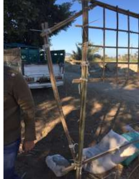
شكل 5-29 تثبيت المظلة: يتم تثبيت الدعائم المائلة بالكمرات الرئيسية و الفرعية. المصدر: الباحث.
