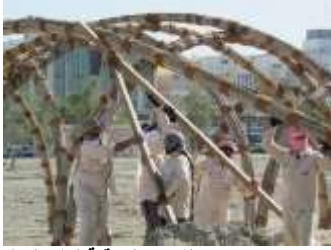
شكل 3- 65 استخدام القوائم المؤقتة لتشكيل العقود المصدر: Peter Shehan, 'Palm Leaves Food Shelter', in Design Boom News Letter < http://www.designboom.com/architecture/sandra-piesik-3-ideas-ltd-food-shelter-the-sabla-al-ain-unesco-03-27-2015/ > [accessed 22 September 2015]
