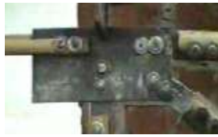
شكل 5- 43 استخدام شرائح الاستيل في المفصلات.
