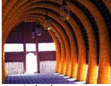
شكل 5- 4 تجميع عناصر البوص على هيئة حزم في نظام حزم البوص في العراق المصدر: Eric Russell and Brindt Smith, 'Mudhif houses capture spirit of Iraqi culture', in The Official Homepage of the United States Army < http://www.army.mil/article/37269/Mudhif_houses_capture_spirit_of_Iraqi_culture/ > [accessed 5 November 2015]
