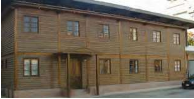
شكل 2- 12 تغطية من ألواح الموسكي و الأبلكاش و قد تم طلاؤها بدهانات مقاومة للعوامل المناخية في مصر بمبنى المصل و اللقاح بهيئة الرقابة الدوائية. المصدر: كتالوج شركة باتجالو للهيكل الخشبية Bungalow Wooden Structures
