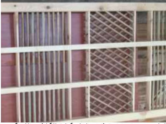
شكل 5-115 استخدام الاطارات الخشبية المنزقة لتثبيت الشبكة المزدوجة و عوارض الجريد المصدر: الباحث من ورشة النجارة، بكلية الهندسة جامعة عين شمس.
