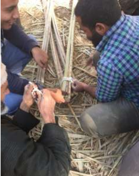
شكل 5- 20التفقيط بحبال الكتان: يتم التغطية بحبال الكتان على الرباط البلاستيكي. المصدر: الباحث
