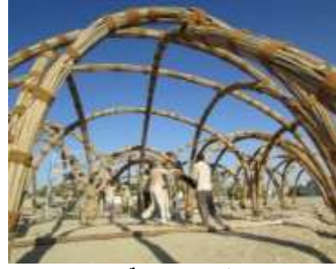
شكل 3- 67 ربط الحزم العقدية ببعضها باستخدام الحبال المصدر: Peter Shehan, 'Palm Leaves Food Shelter', in Design Boom News Letter < http://www.designboom.com/architecture/sandra-piesik-3-ideas-ltd-food-shelter-the-sabla-al-ain-unesco-03-27-2015/ > [accessed 22 September 2015]
