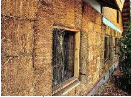
شكل 2-17 بالات القش كحوائط حاملة، حيث يمكنها أن تحمل وزن السقف بالإضافة إلى أحمال الرياح و الثلج
