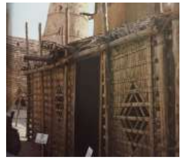
شكل 3- 72 الحائط بنظام الجريد المستمر المصدر: Piesik, Sandra, Arish: Palm-Leaf Architecture, 2nd edn (London, UK: Thames & Hudson, 2012) (p. 131).
