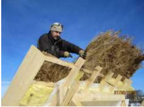
شكل 3- 51 تشذيب بقايا البوص بعد انتهاء تركيب طبقات البوص المتراكبة المصدر: Lautkankare, Rauli, 'The Fire Test of Thatched Roofs', in Guide Book of Reed Bussiness: Central Baltic Integration Program , ed. by Anne Hemmi (Estonia, Finland: European Regional Development Fund, 2013), pp. 32-37 (p. 2).
