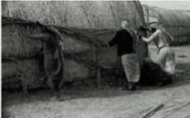
شكل 3- 37 تثبيت الحصر المصنوع من البوص على السطح للحماية من الحرارة
