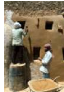
شكل 1- 13 مشاركة الشباب السيوي في أعمال البياض الداخلي المصدر: Alamuddin, Hanan, Adrere Amellal Eco Lodge Technical Review Report (Siwa Oasis, Egypt: Siwa Sustainable Development Initiative, 2001) (p. 54).
