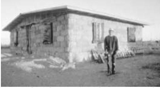
شكل 1- 18 بيت خوسيه لويس بقش الارز و الخشب المبتني بالجهود الذاتية في انبارا بالمكسيك من انجازات حركة بنائون بلا حدود
