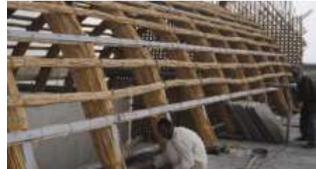
شكل 3- 35 ربط بوص التغطية بالعقود بالحبال
