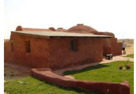
شكل 2-15 منزل بنظام الحوائط الحاملة ببالات قش الارز المصدر: أسماء قنديل, 'جيهان لطفي. حلت مشكلة الإسكان والسحابة السوداء بمنازل "قش الأرز", "صحيفة روز اليوسف- صفحة موهوبون <> [accessed 25 October 2015]
