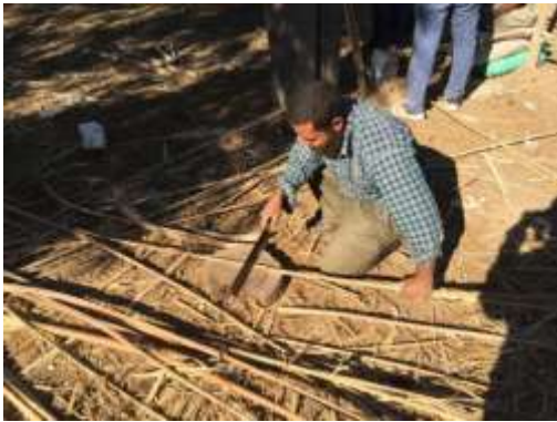
شكل 5-16 قص الجريد: عند تقطيع أكثر من جريدة بنفس الطول يتم استخدام أول جريدة تم قطعها كطول مرجعي لتقطيع باقي الجريد. المصدر: الباحث
