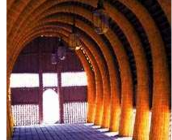
شكل 5- 34 حزم البوص بالمضيف العراقي: الاعتماد على مساحات مقطعية كبيرة لزيادة عزم مقاومة الانحناء. المصدر: Almssad, Asaad and Almusaed, Amjad, 'Building materials in eco-energy houses from Iraq and Iran', Case Studies in Construction Materials , 2 (2015), 42-54.
