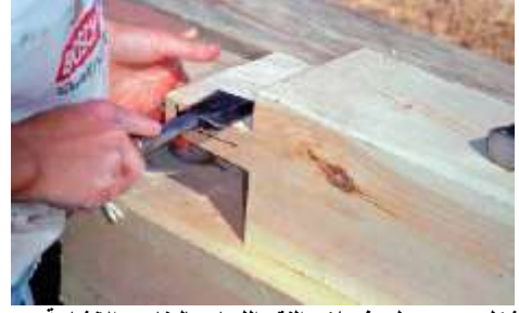
شكل 3- 4 عمل مفصلات النقر اللسان بالعناصر الإنشائية للإطار الهيكلي
