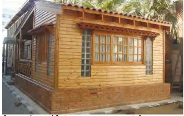
شكل 3- 11التكسية بألواح الموسكي و القراميد الطينية في المنشآت السياحية في مصر
