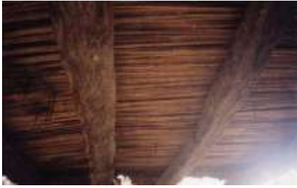
شكل 2- 55 التسقيف بسدد الجريد من الداخل. المصدر: أيمن عتبة and عفيفي، إيهاب، 'استخدام المخلفات الزراعية في المنشآت الريفية in مؤتمر مستقبل التنمية المستدامة في مصر (القاهرة، مصر: وزارة التنمية المحلية المصرية، 2012، 184-99 II), (p. 6).
