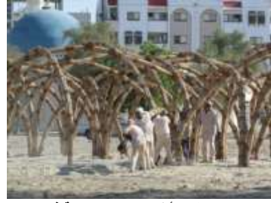
شكل 3- 66 تثبيت أطراف الحزم العقدية في الارض المصدر: Peter Shehan, 'Palm Leaves Food Shelter', in Design Boom News Letter < http://www.designboom.com/architecture/sandra-piesik-3-ideas-ltd-food-shelter-the-sabla-al-ain-unesco-03-27-2015/ > [accessed 22 September 2015]
