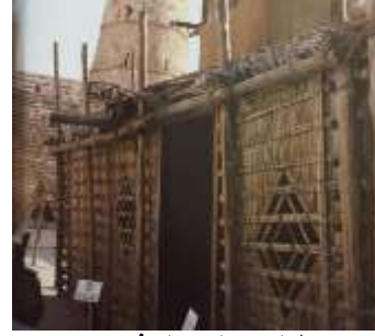
شكل 1- 8 حوائط الجريد المجدول في الإمارات المصدر: Piesik, Sandra, Arish: Palm-Leaf Architecture , 2nd edn (London, UK: Thames & Hudson, 2012) (p. 131).
