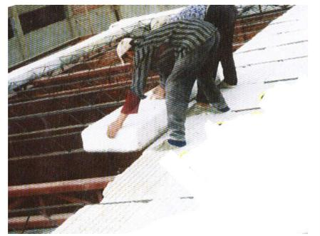
شكل (٦-١): طريقة تنفيذ الأسقف الخرسانية المرتكزة على الأعصاب الحديدية. (١٠٢، ص ١)
