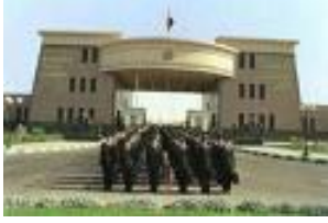
شكل (8-7): بوابة أحد المنشآت التابعة لوزارة الداخلية (أكاديمية مبارك) الواقعة بالقاهرة الجديدة محافظة حلوان والمتاخمة لمنطقة الدراسة. المصدر: الباحثة.
