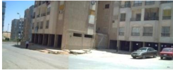
شكل (7-60): وجود بعض البواكي غير المستغلة والتي يمكن الاستفادة منها في إضافة أنشطة واستعمالات تصيف حيوية للفراغات الخلفية. المصدر: الباحثة.
