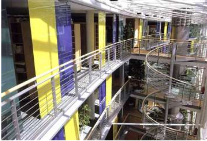
شكل ( 8-25 ) استخدام القواطع المنزلقة للتحكم في الإضاءة الطبيعية المصدر ( Links International , 2003 )
