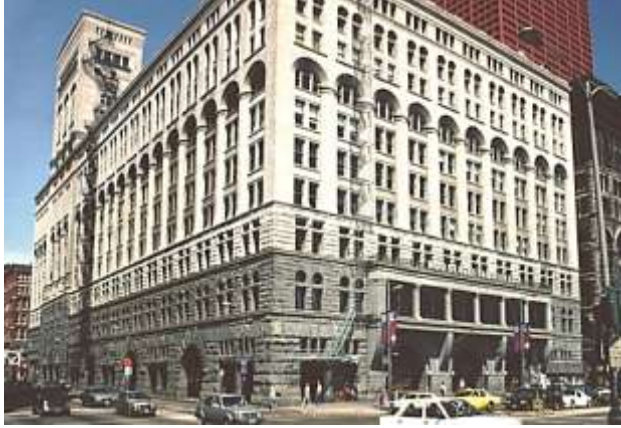
شكل ( 1-2 ) مبنى Auditorium Building، إبنوى ( 1890 ) للمعماري سوليفان المصدر ( www.greatBuildings.com )
