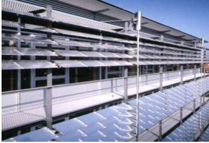
شكل ( 6-19 ) استخدام الكواسر الشمسية على النوافذ للتحكم فى أشعة الشمس المصدر ( www.bomin-solar.de )
