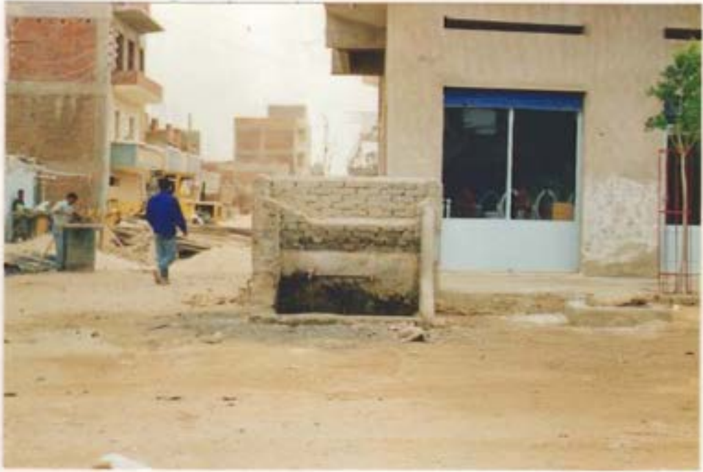
شكل (٣-٣٦) : صنبور مياه عام بالمنطقة الجديدة "حى السلام" ويظهر بالشكل الطرق الثانوية الممهدة بترية زلطية
