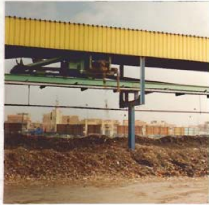
شكل ( ٤ - ١٧ ) : السير الأفقى ويظهر عليه عمرة توزيع السماذ
