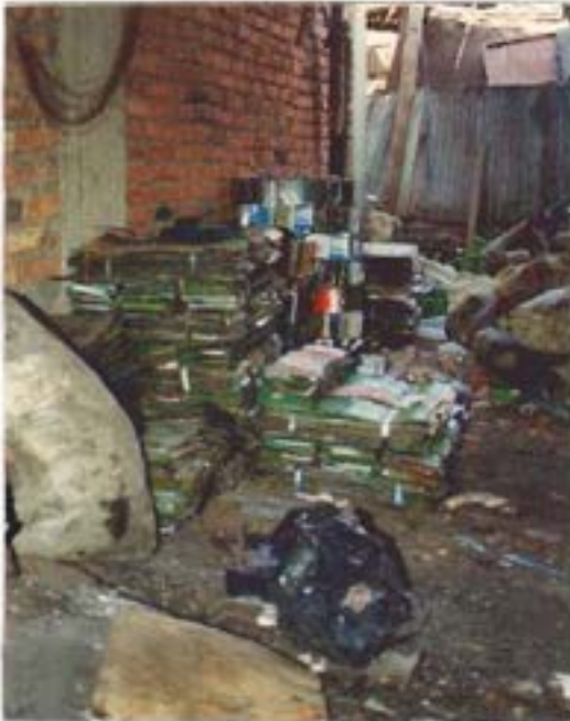
شكل (٥ - ٤٦) : تجميع الصفائح المسترجع على شكل حيزم بعد تسطيحه ، تمهيدا ليبعه للورش المجاورة
