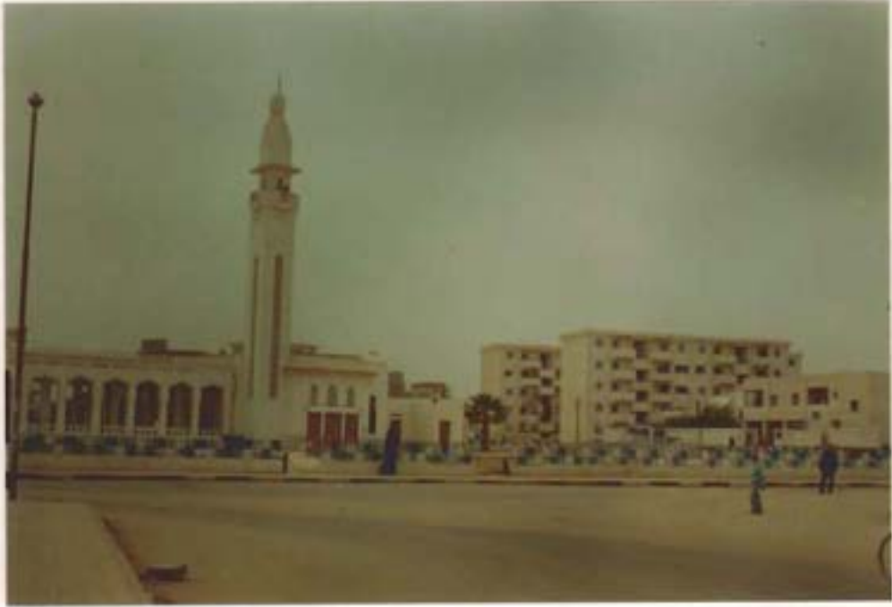
شكل (٣-٢٧) : مركز "حي السلام" - القطاع ١٦ - ويظهر به بعض الخدمات (جامع ، مركز طبي ، قسم شرطة ، مساكن ااحلال )
