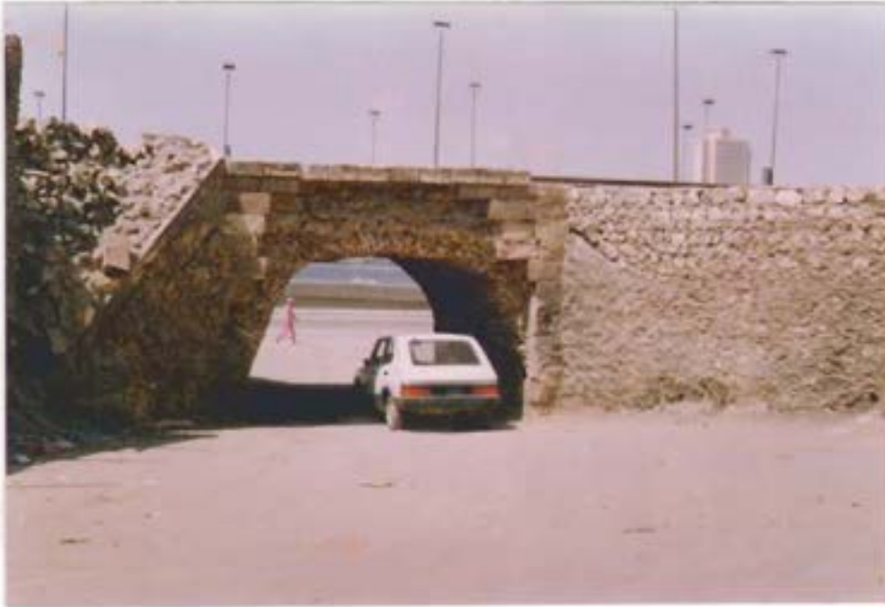
شكل ( ٤ - ٤٩ ) : النفق الذى يقع تحت خط السكة الحديد - مدخل رقم ٢ * منشأة ناصر * - ويربط بين طريق النصر وشارع السكة الحديد ، ويؤدى إلى المدخل الشرقى رقم ٢ * لمنطقة الزهاين * ( شارع حكيم عطا الله )
