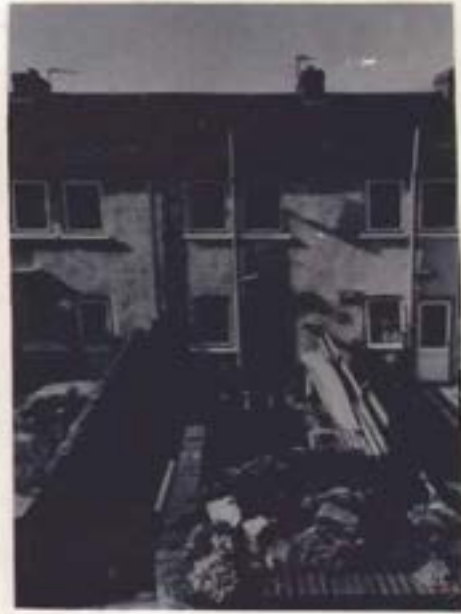
شكل ( ٧٨-٣ ) : مسكن العمارى الذى تم الانتهاء منه فى بداية المشروع ليكون نموذجا إرشاديا للأعمال التى يمكن إنجازها بالجهد الذاتية ، والأخرى بواسطة عمال البناء .
