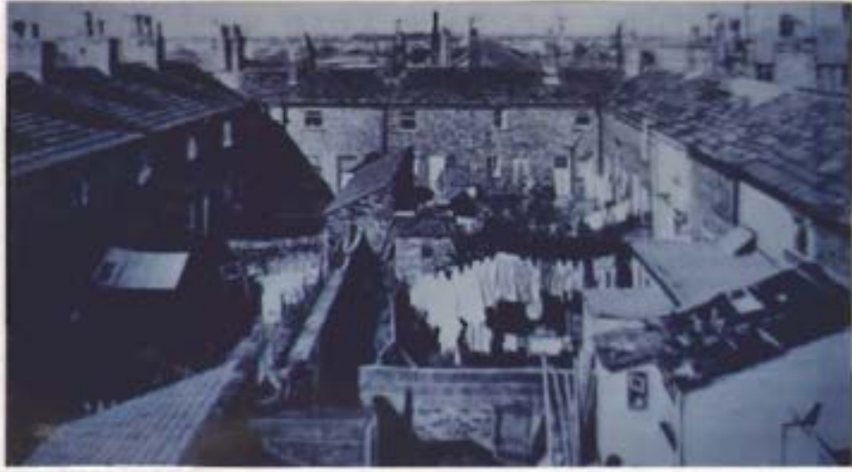
شكل (٣-٧٩) : شكل الأبنية قبل مشروع الإرتقاء
