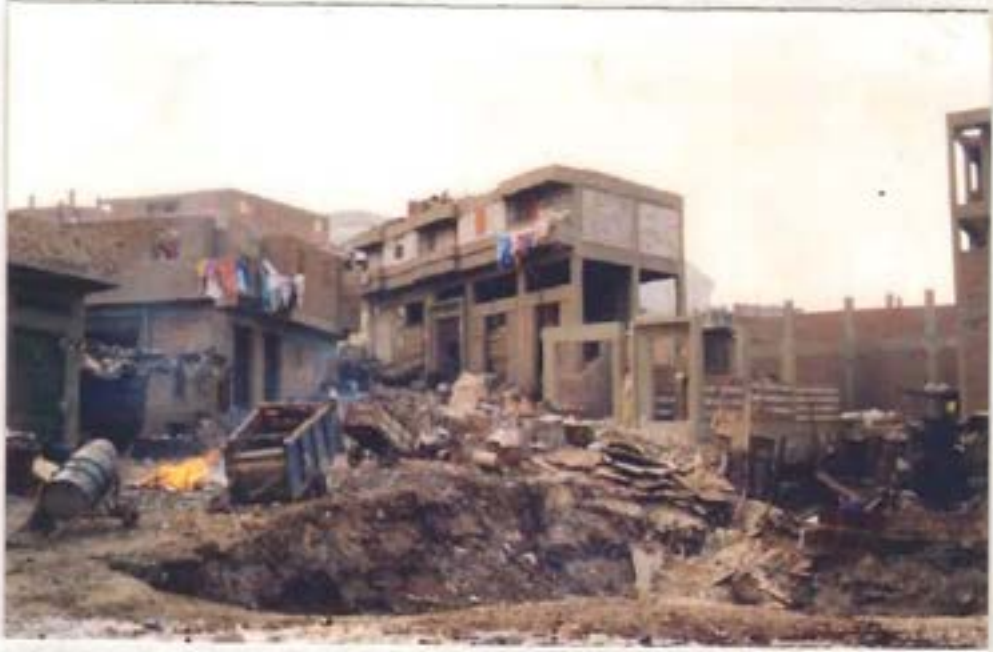
شكل ( ٤ - ٤١ ) : مطلع طريق يزدي إلى " القطاع العلوي " المرتفع ، ويلاحظ اشعال النار في الورق والمخلفات غير المرغوب فيها مما يؤدي إلى اشغال الطريق وتلوث الجو ، ومثل هذا المطلع لايمكن سير أى نوع من المركبات به
