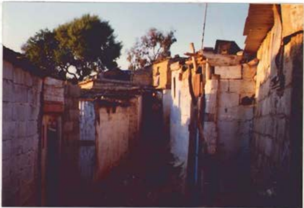
شكل (٣-٥١) : إحدى الطرقات داخل الحى [٢]
