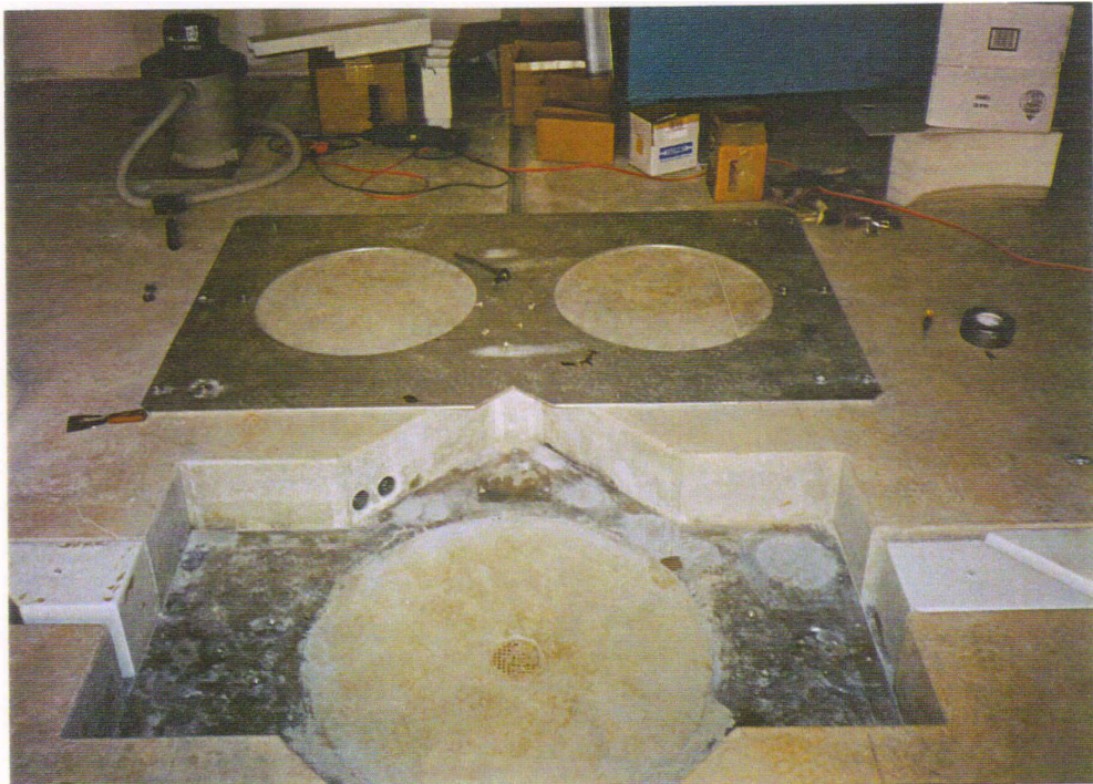
شكل رقم (٨٩) توصيلات الأرضية بالفراغ الداخلي
