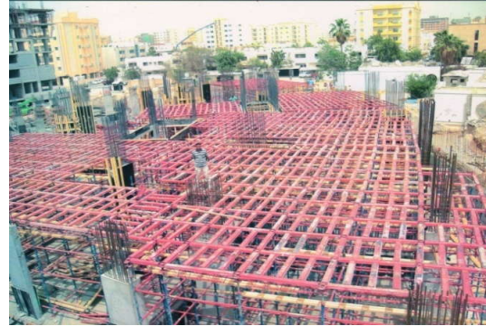
شكل رقم (١٢٦) عناصر الشدة قبل التطبيق بالالواح شكل رقم (١٢٧) عناصر الشدة المعدنية اللازمة
