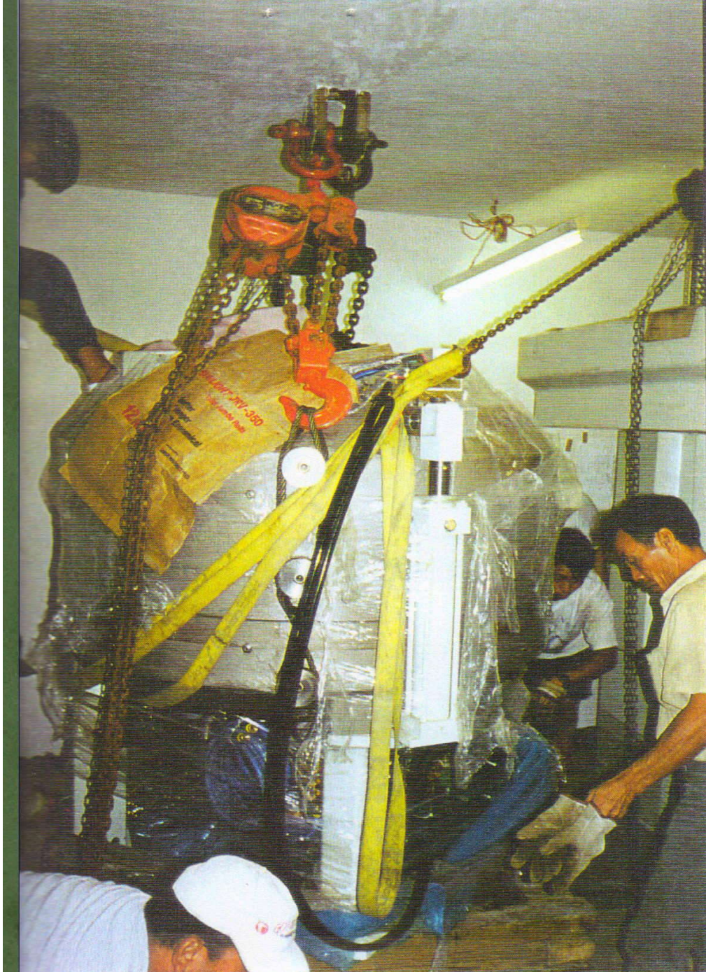
شكل رقم (٩٥) طريقة تحميل الجهاز من السقف الخرساني بالفراغ الداخلي
