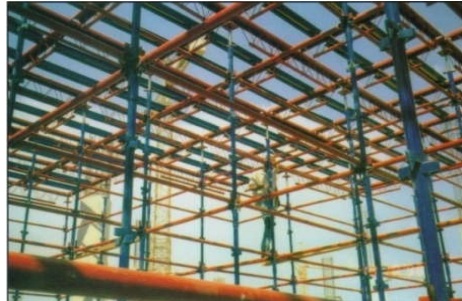
شكل رقم (١٢٣) يوضح نموذج للشدة المعدنية التى تستعمل فى الأسقف السميكة
