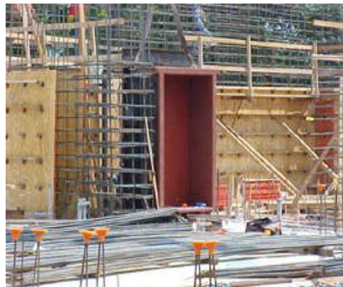
شكل رقم (١٠٧) طريقة تركيب الباب أثناء التنفيذ
