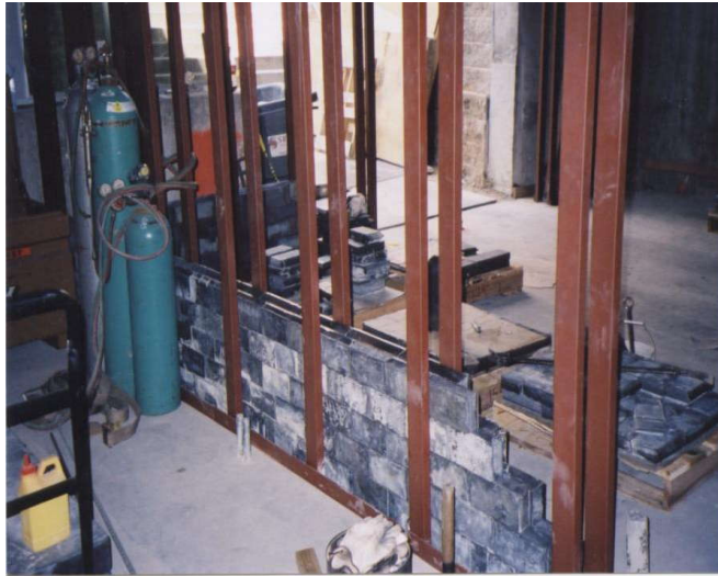
شكل رقم (١١٧) طريقة تركيب بلوكات من الرصاص
