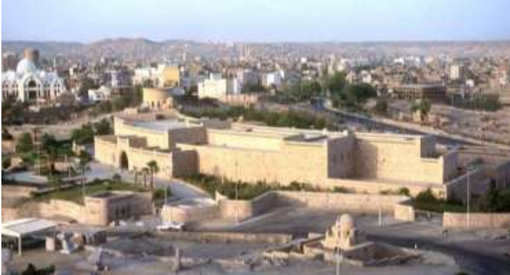
(شكل ١١-١١) مثال لاتجاه المحلية الجديدة كمدخل رمزي في تصميمات المتاحف متحف النوبة - أسوان- مصر للمعماري محمود الحكيم المصدر : www.akdn.org
