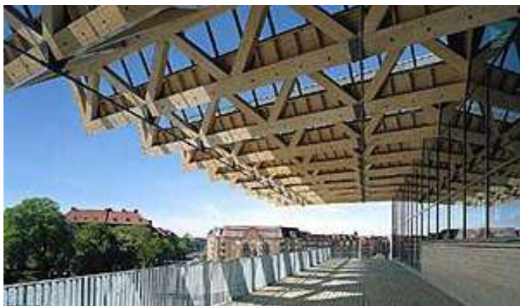
(شكل ١١-١٢) التعبير بعناصر الإنشاء كمثال على المدخل الوظيفي في تصميم المتاحف Wingårdh Arkitektkontor AB The Universeum, Göteborg, Sweden المصدر : www.arcspace.com
