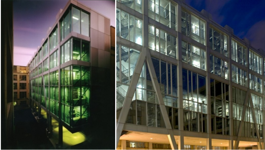
شكل رقم ١٢٢ الإنشاء المعدني للمكتبة مغطى بالزجاج (MIT Rotch Library)
