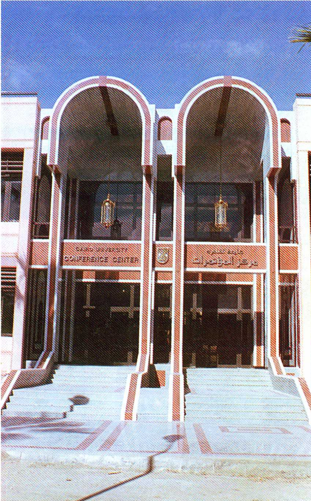
واجهة المدخل الرئيسي
