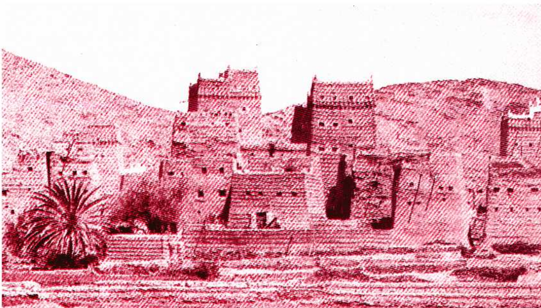
مبنى طين بمدينة نجران حيث تظهر خطوط مداميك الطين على واجهة المبنى
