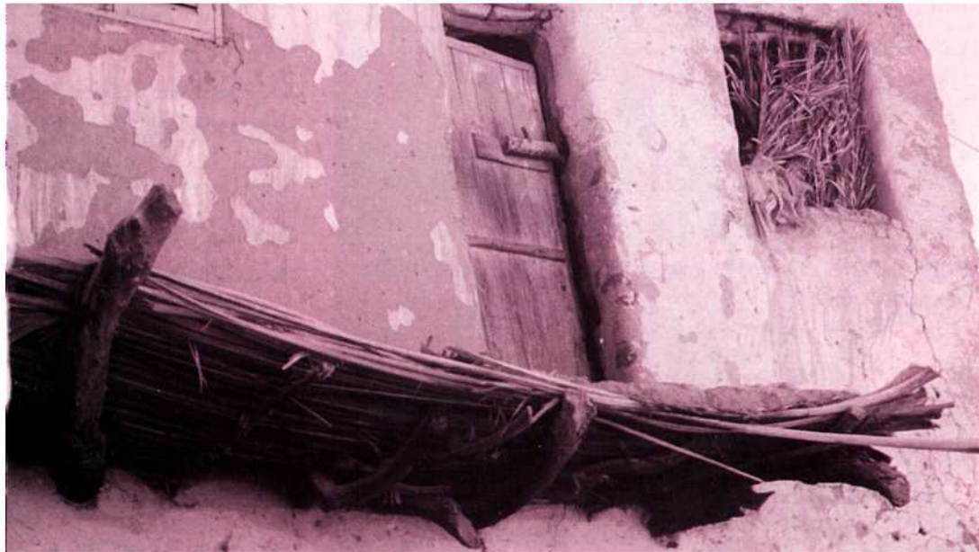
شكل (١١) طريقة إنشاء الكوابيل البدائية كانعكاس إمكانيات مواد البناء المحدودة
