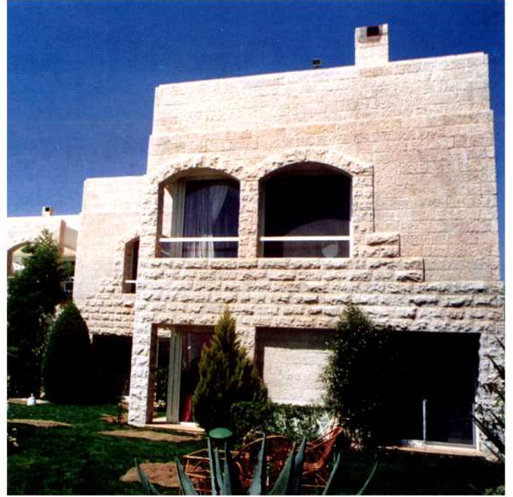
واجهة على الحديقة توضح استعمال ملمس الحجر في الواجهة
