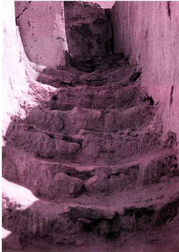
شكل (١٣) طريقة تشطيب درج السلم بلياسة من الطين والطفلة
