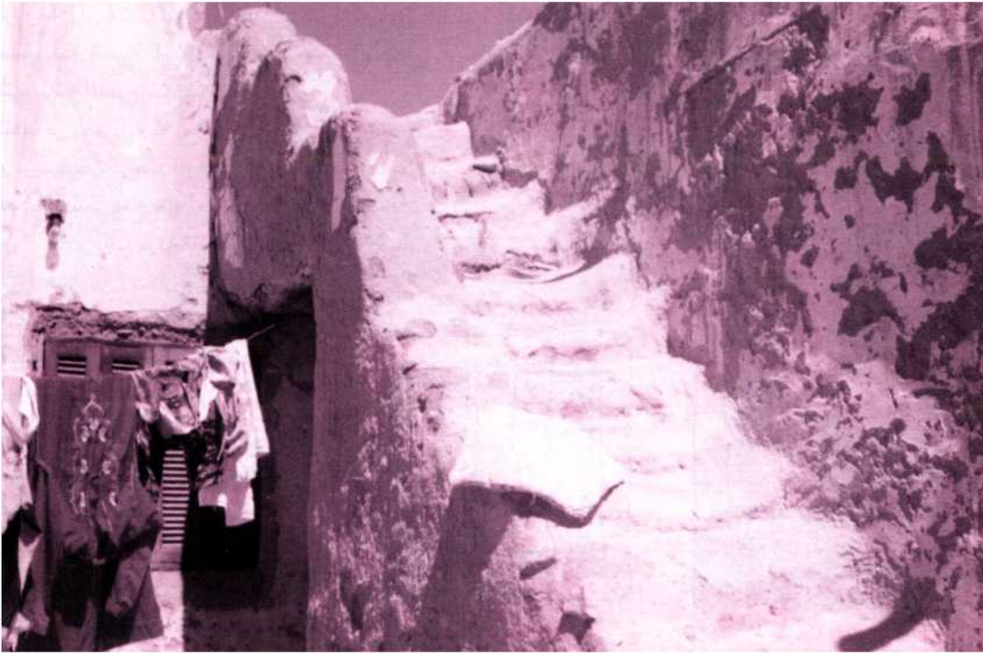
شكل (١٢) طريقة إنشاء السلالم وتشطيبها واستغلال أسفلة الدرج في عمل تجاويف تستغل كدوابل للتخزين
