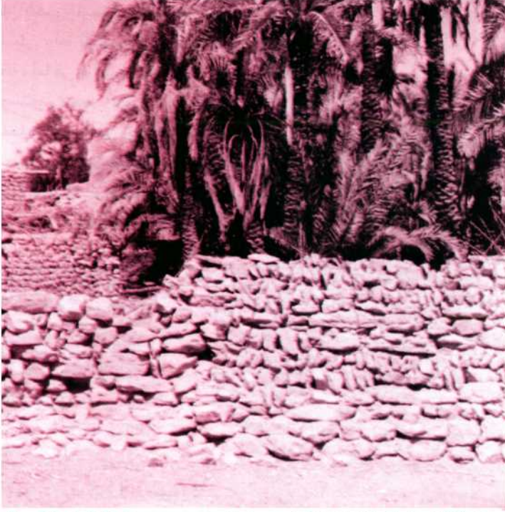
شكل (٦) إنشاء الحوائط الحاملة واستخدام الحجارة بدون صقل (الواحات البحرية)
