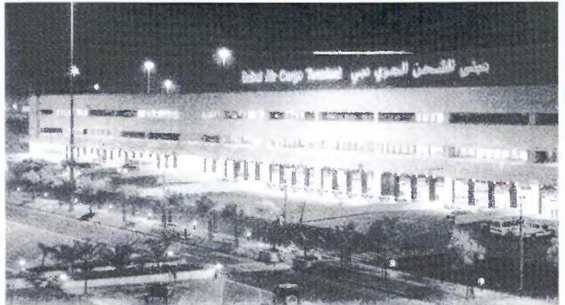
مبنى الشحن الجوي بمطار دبي
