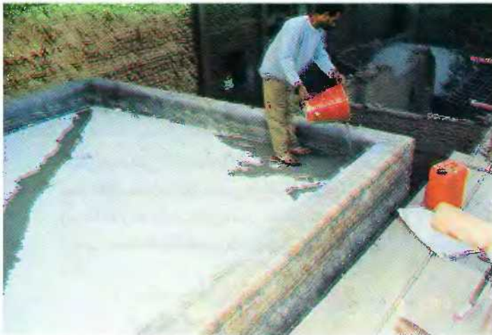
ترميم أهد الأسقف ببيت السحيمي
