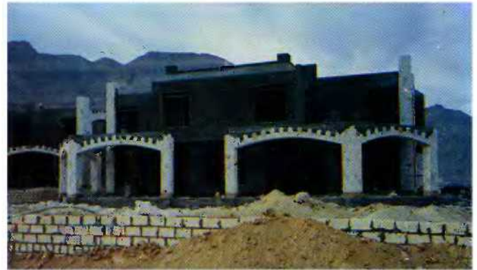
Projects in El Ein El Sokhna under - construction
