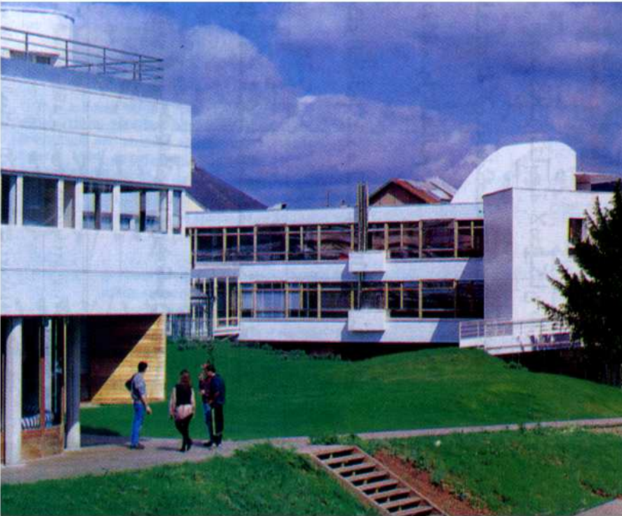
جزئى المبنى يحصران فيما بينهما حديقة داخلية
