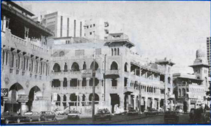
مصر الجديدة توفرت بها وحدة الطابع باستخدام وحدات نمطية في معالجة الواجهات
