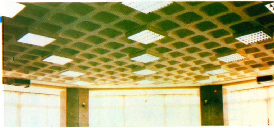
وحدات Waffle Slab المنفذه بالصالات المشنة.
