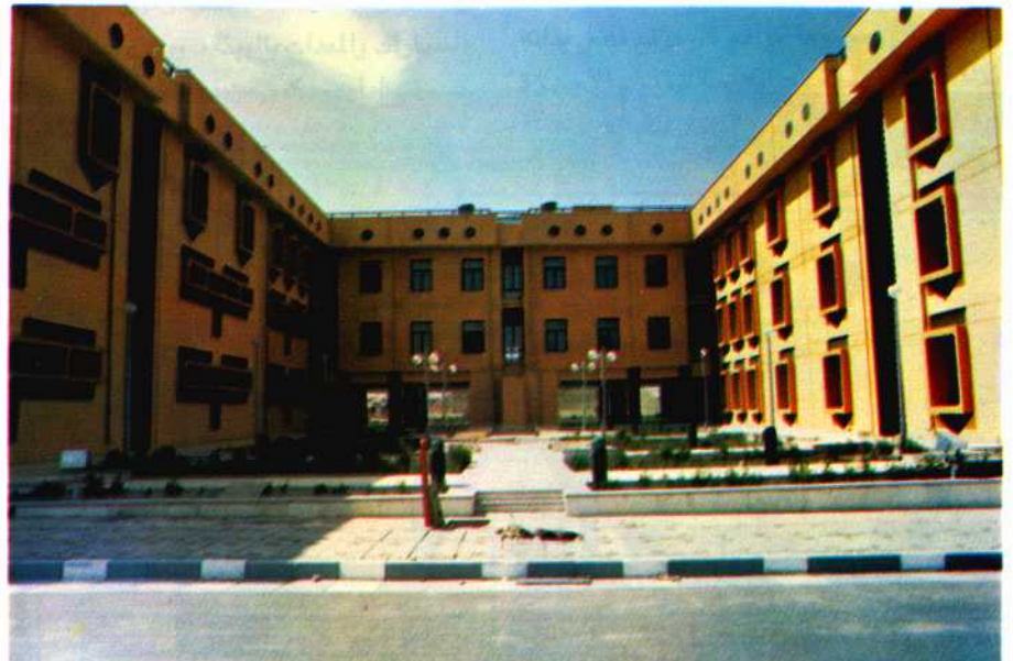
الواجهة الخلفية للمبنى
