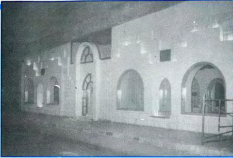
واجهة خارجية للمشروع من الشارع حيث يظهر جسم الكوبري أعلى المحلات
