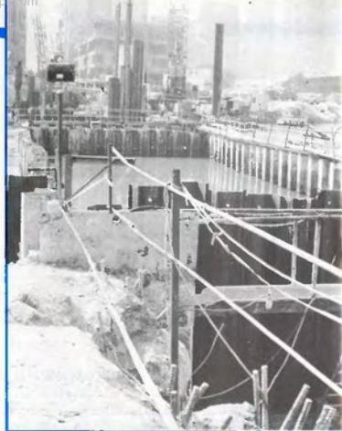
حجز المياه حتى يتم الانتهاء من صب السقف
