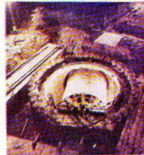
عودة آلة TBM الي التاسون بعد حفر مسارات النفق
