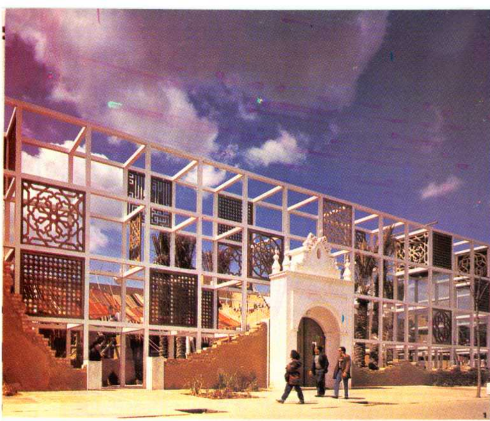
2 الحائط من الطوب اللبن والذي يتأكل ليظهر خلفه الهيكل المعدني الذي بنيت به وحدات علي هيئة المشربية
