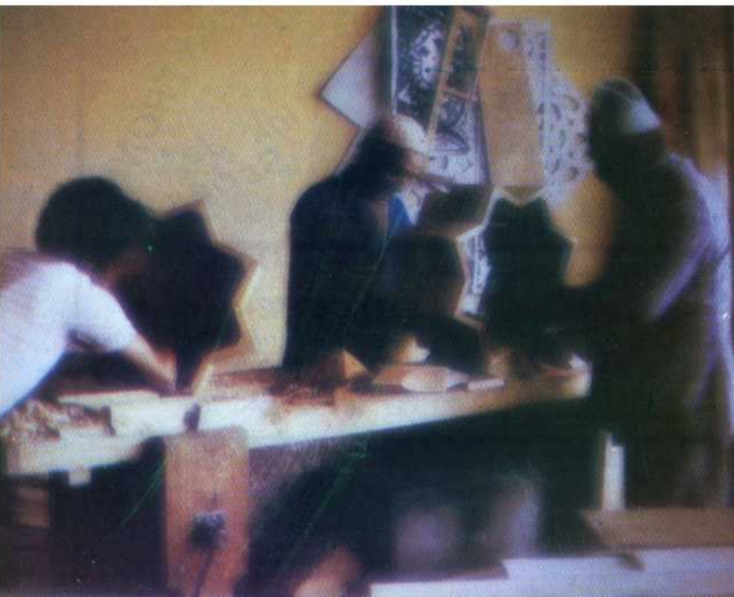
بناء شاشيه القبة قبل تركيبها و تثبيت المقرنصة عليها
