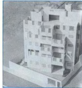
شكل (٢) مثال عملي لعامة سكنية نموذجي جسم للمبني يوضح فكرة الخارجات المتبادلة
