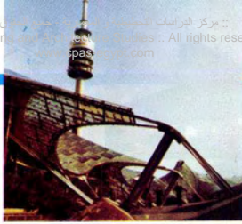
سقف منشآت الصالات الأولمبية بميونخ المكونة من كوابل شبكية من الصلب
