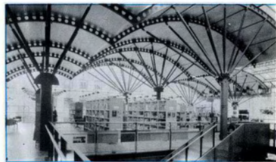
الهيكل الإنشائي من الأفرع الرقيقة والمنحنيات
