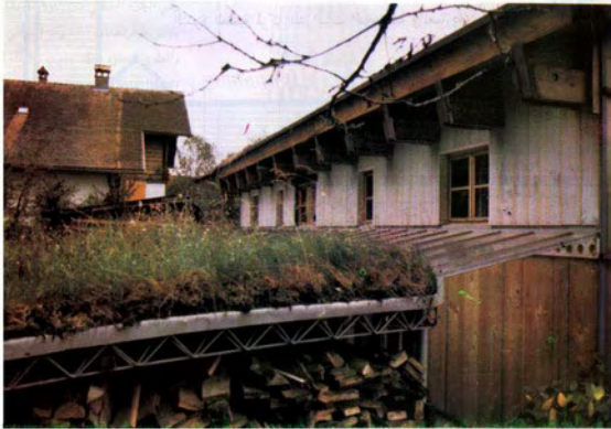
تغطية الاسقف بطبقة طينية تثبت عليها الحشائش لتحقيق الاندماج مع الطبيعة العزل الحراري
