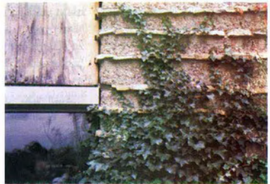
لتقوية الحائط يوضع القرميد القديم لتسليح الحائط المبني من الطين المخلوط بالقش
