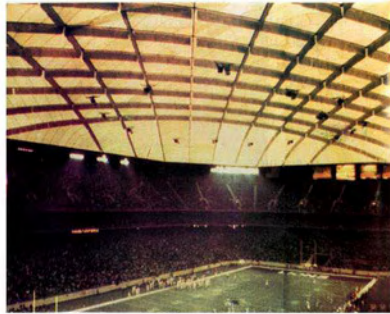
سقف استاد بونتياك (Pontiac) المرفوع بضغط (الإبعاد الداخلية ٧١٧×١٦٦ متر).
