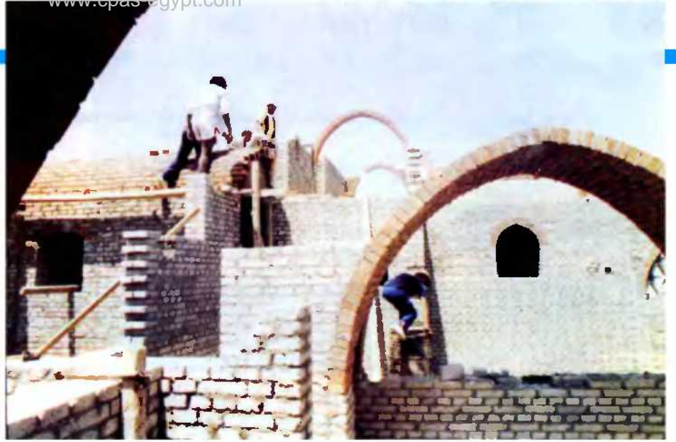
الفيلاء أثناء عملية التنفيذ و تظهر طريقة بناء العقود و القباب
