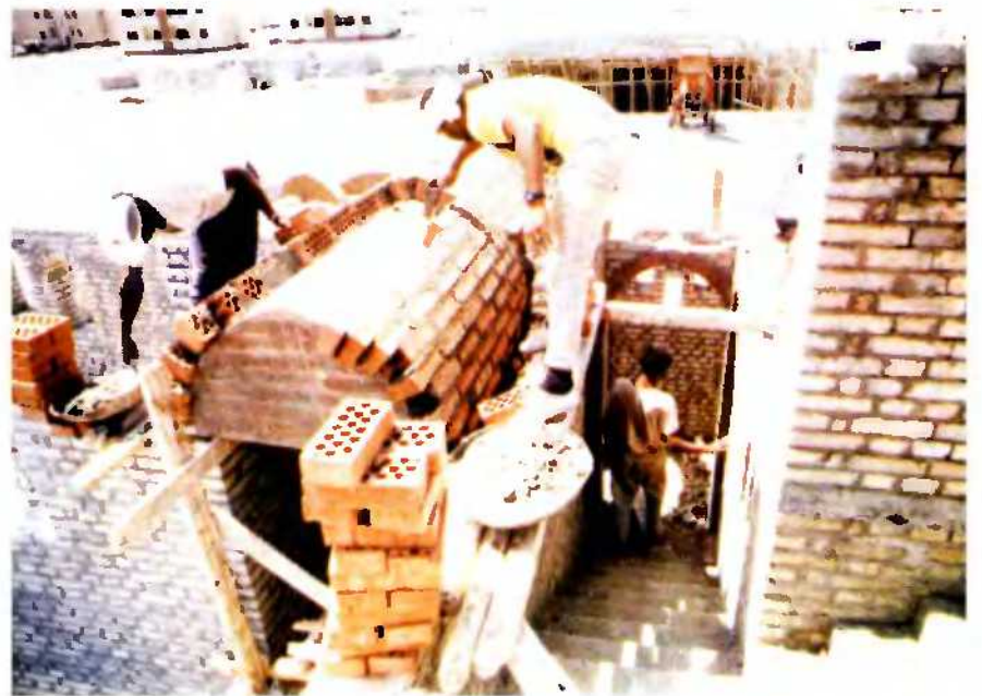
تم عملية التنفيذ بواسطة عمال مهرة محلين - بناء القبو باستخدام شدة
