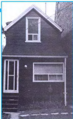
الواجهة القديمة للمنزل
