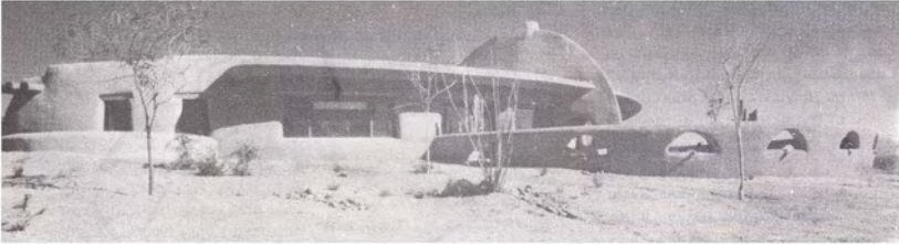
الواجهة الجنوبية للمبنى ذو الحوائط الطينية المدعومة باللون المقارب للطبيعة حوله أريزونا
