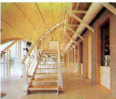
السلام المعدنية المادية للطابق العلوي ويظهر بالصورة الدعامة المعدنية التي تحمل المر الخشبي العلوي.
