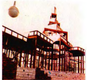
الهيكل الإنشائي المكون من قطاعات الصلب الثقيف
