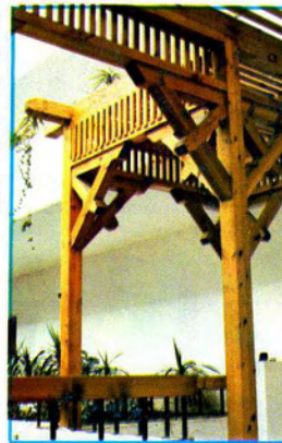
تفصيله فى المظلات القصبية المستخدمة فى تظليل الفراغات المفتوحة بالمبنى الإدارى
