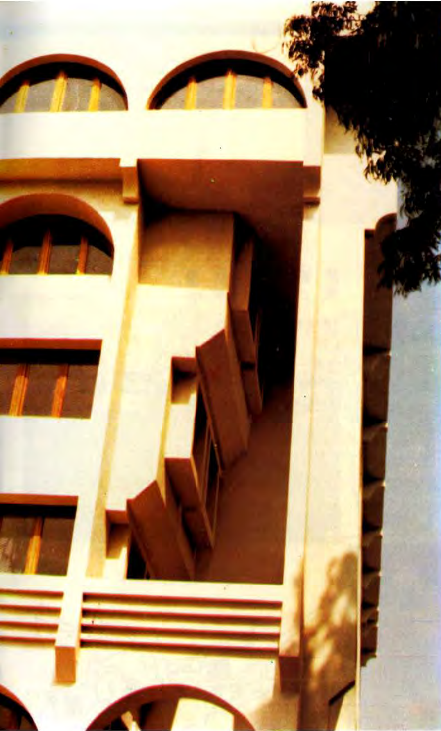
المعالجة النحتية لأركان المبنى
