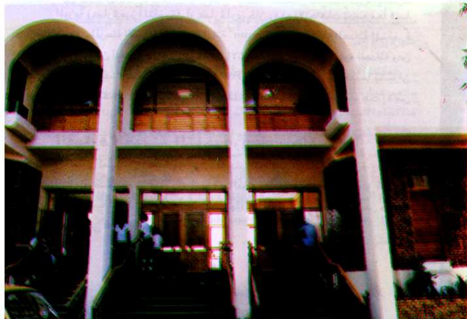
استخدام الطوب الحرارى مع بياض الحجر الصناعى فى معالجة الواجهات الخارجية - المدخل الرئيسى
