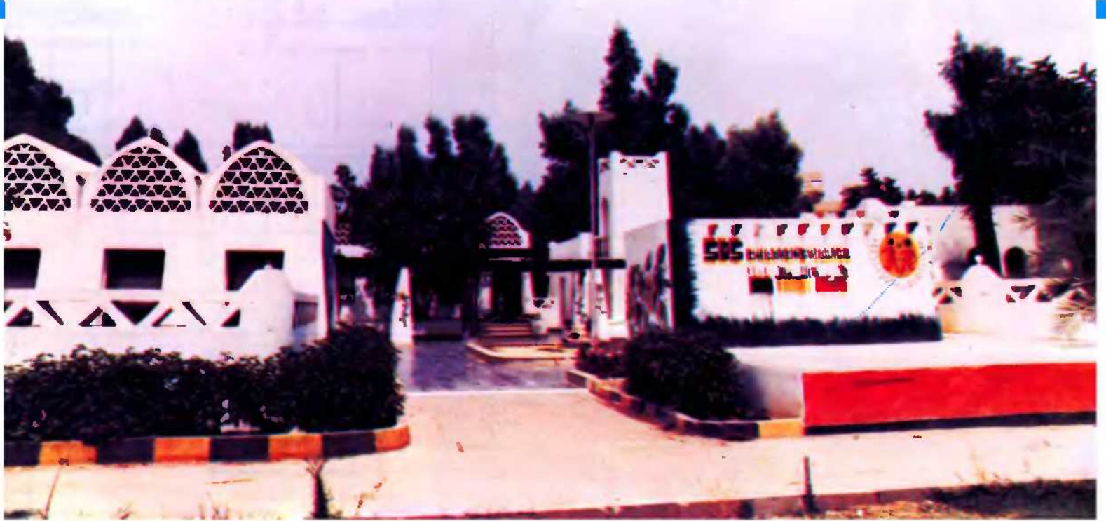
مشروع العدد: مبنى العضاة ويمثل المدخل الرئيسي للقرية، وقد روعي أن تزدان حوائطه بالرسومات الملونة المحببة للطفل
