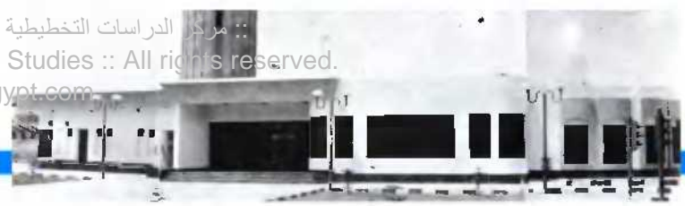
الواجهة الخلفية للمبنى
